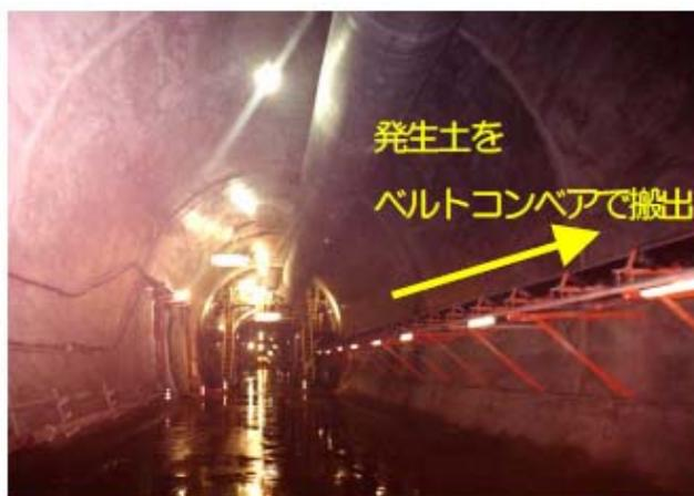
新方式（ベルトコンベア方式）
