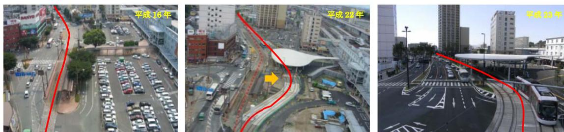
写真 5-28 路面電車のサイドリザベーション化
