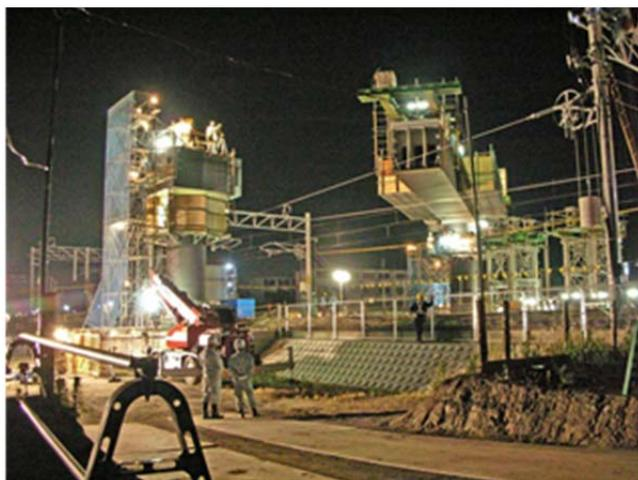
写真 5-38 横梁回転工法施工状況
