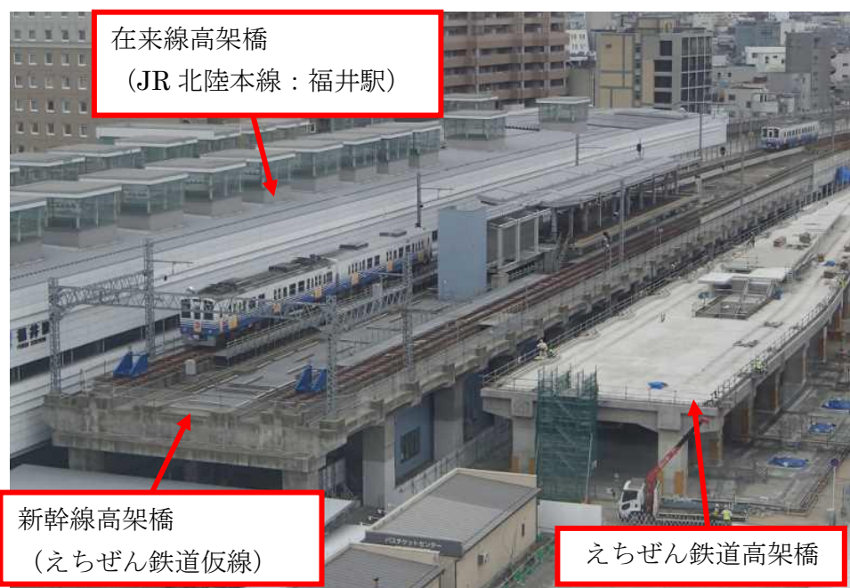
写真 5-5 福井駅立体交差事業
