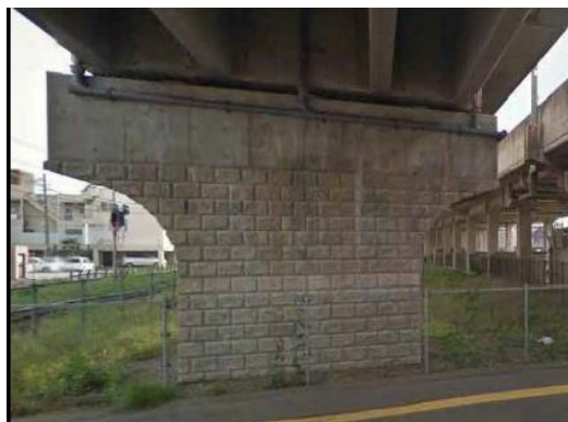
写真 5-9 日の出架道橋
