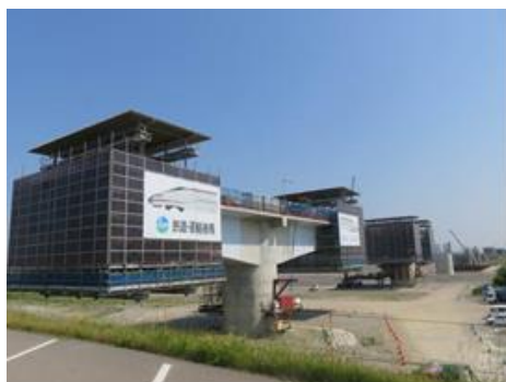
写真 5-2 手取川橋りょう
