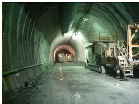
写真 5-1 新北陸トンネル
