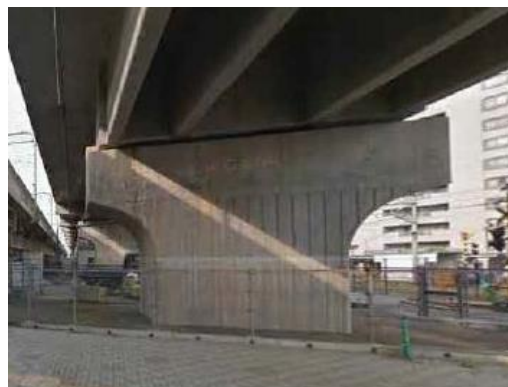
写真 5-10 第4 大手架道橋
