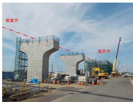
写真 5-3 川北橋高架橋
