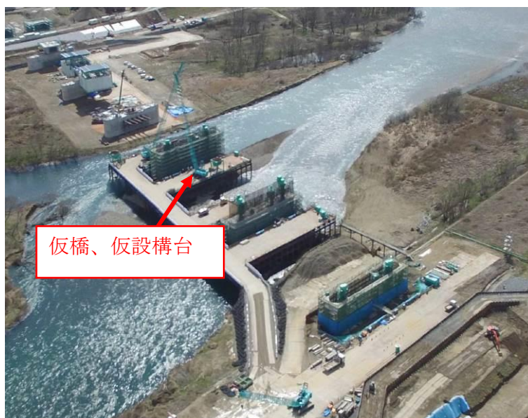
写真 5-7 九頭竜川橋りょう(仮橋、仮設構台)
