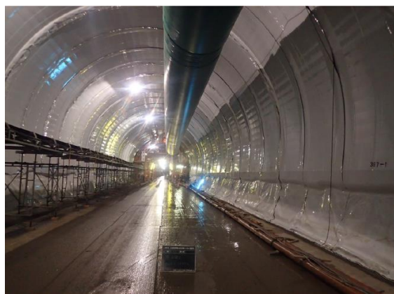
写真 5-6 新北陸トンネル
