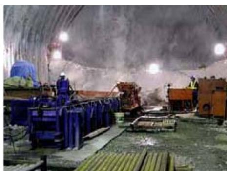
写真-11 先進水平ボーリングの施工
