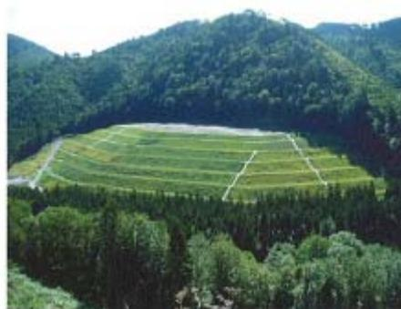
土捨場のトンネル掘削発生土を遮水構造の二重シートで覆った後、緑化を行っている。
