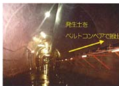
新方式（ベルトコンベア方式）の掘削土の運搬
