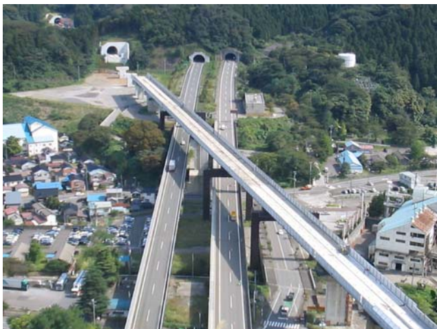
写真－2 北陸道架道橋
