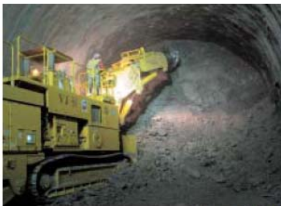
写真-10 峰山トンネル掘削状況
