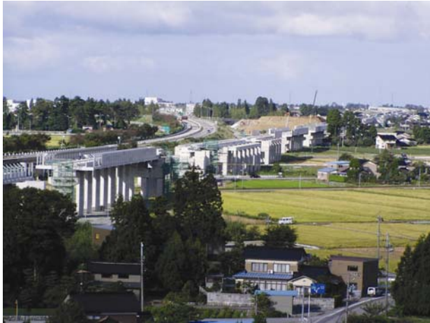
写真－4 新黒部駅付近の高架橋(工事中)
