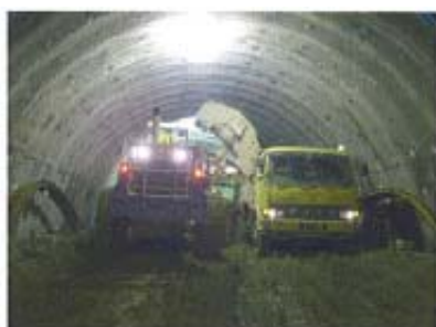
従来方式（タイヤ方式）の掘削土の運搬
