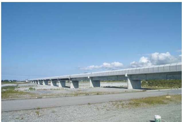
写真－3 黒部川橋梁
