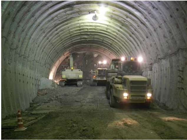
写真－1 飯山トンネル(工事中)
