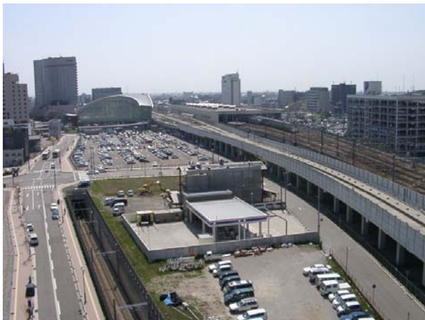
写真－5 金沢駅付近の高架橋
