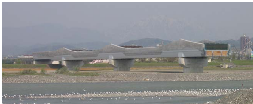
写真-8 姫川橋梁（工事中）
