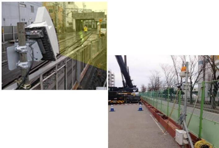
写真 5-10 レーザーバリア(空中越境監視装置)
