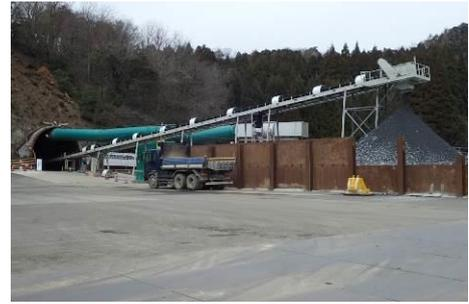
新方式（ベルトコンベア方式）の掘削土の運搬
