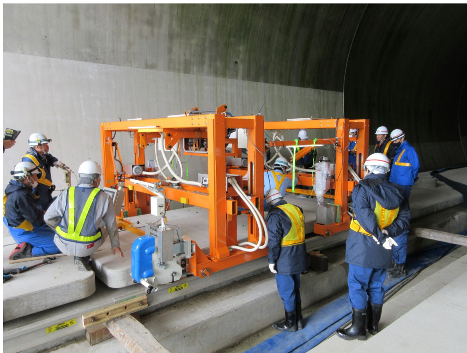
軌道工事におけるスラブ調整作業の電動化
