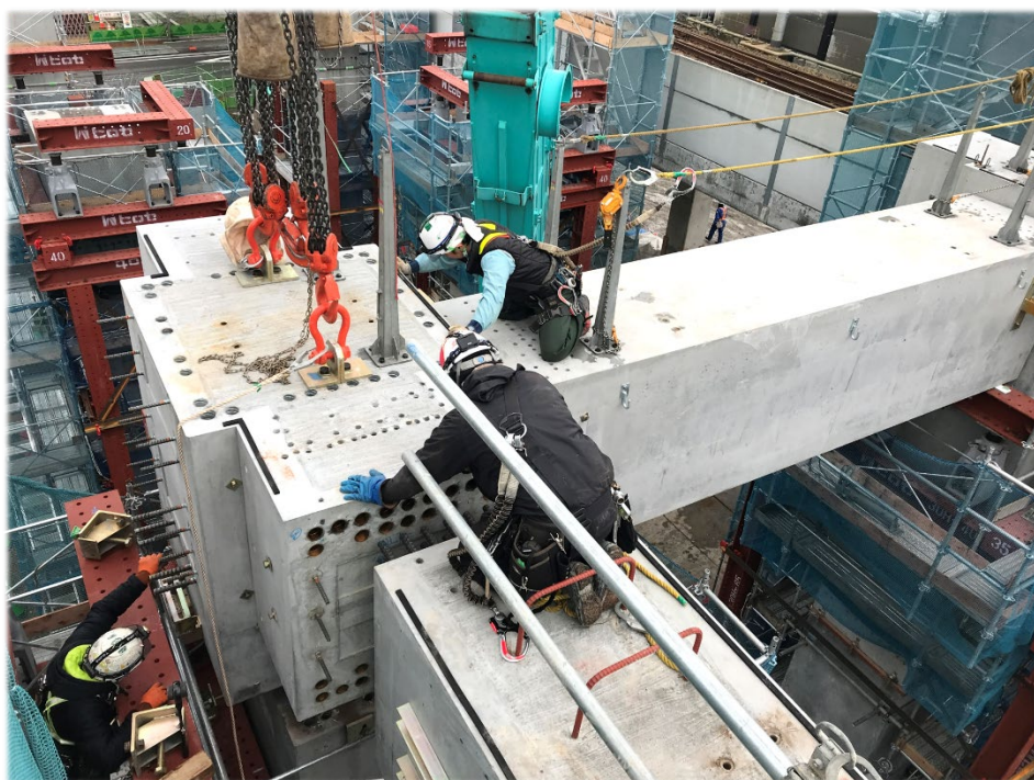
工場製作した大型プレキャストコンクリート によるラーメン高架橋工事
