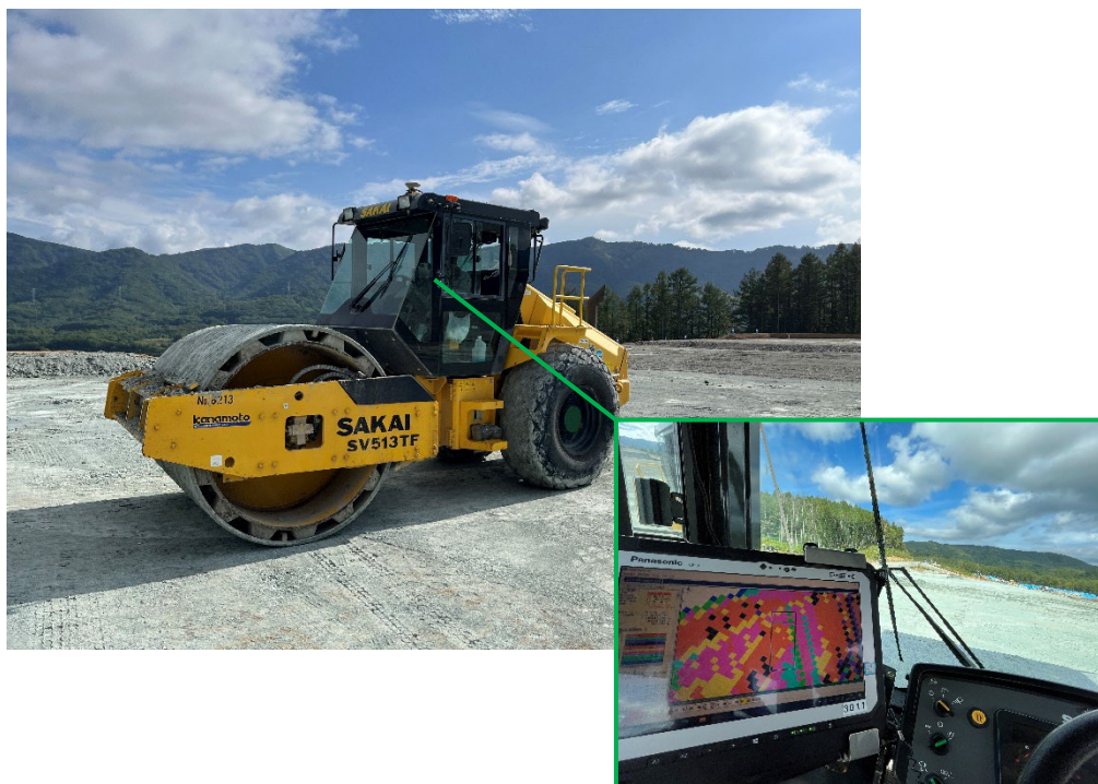
ICT施工の状況
