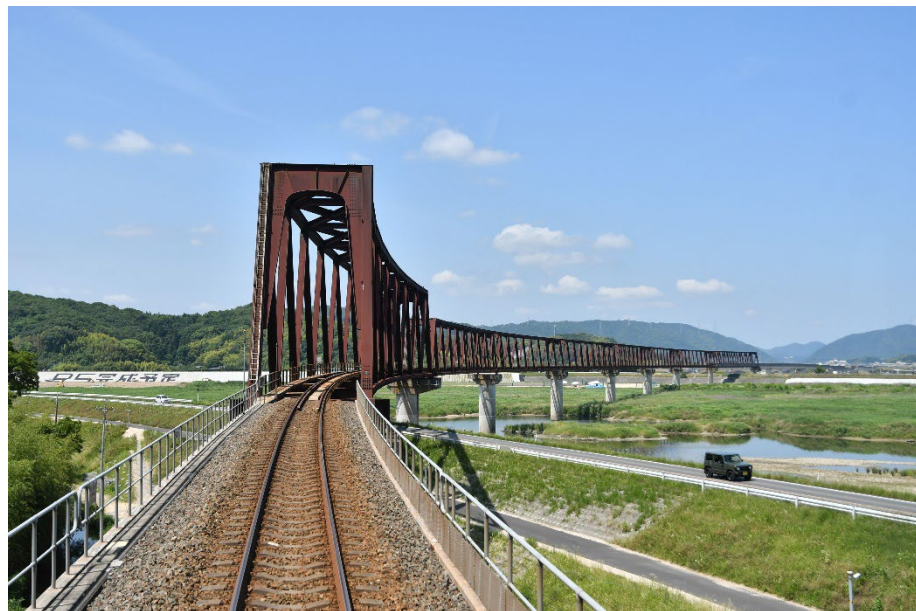
電炉鋼を活用した橋梁（井原線・高梁川橋梁）
