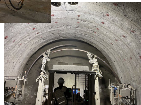
全自動の鋼製支保工組立ロボット
