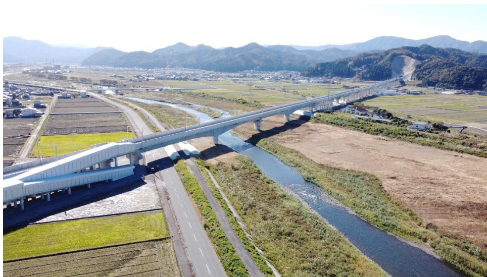
高炉スラグセメントを活用した橋梁 (北陸新幹線・日野川橋りょう)
