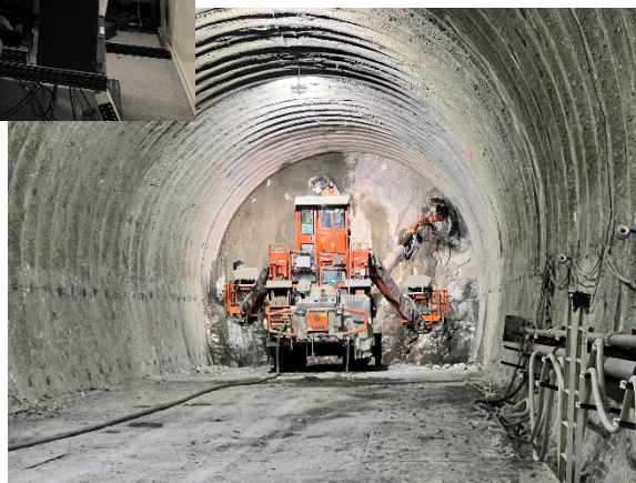
遠隔操作による山岳トンネル掘削
