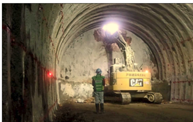
写真 1.1.1-6 諫早トンネルの工事状況
