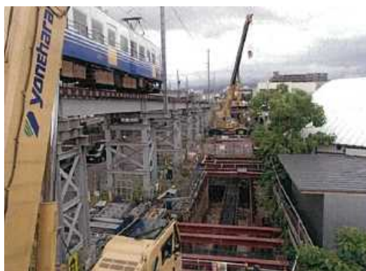
写真 1. 1. 3-1 営業線近接工事の状況
