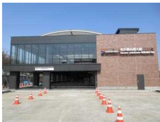
写真 1. 1. 2-2 羽沢横浜国大駅の外観
