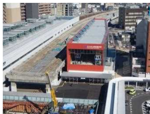
写真 1. 1. 3-2 計画線供用後、仮線を撤去完了した状況
