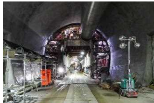
写真 1.1.1-1 昆布トンネル（北海道ニセコ町）の施工状況
