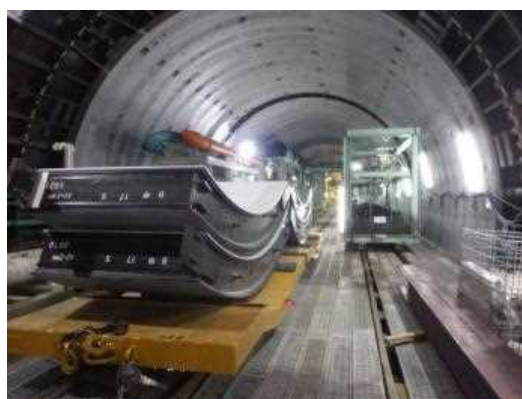
写真 1. 1. 2-4 新横浜トンネルの施工状況
