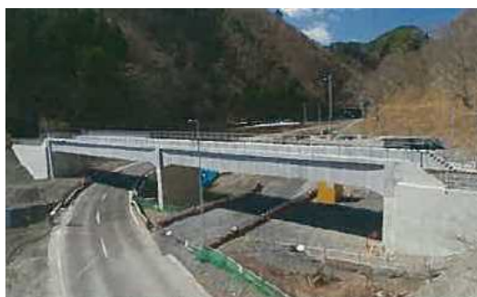
写真 1.1.4-1 建設された「GRS 一体橋梁」 三陸鉄道ハイペ沢橋梁
