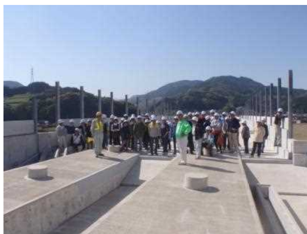
写真 1.1.4-2 現場見学会の状況 (九州新幹線、嬉野温泉駅高架橋)
