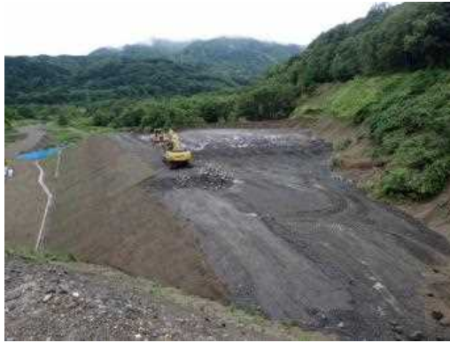
写真 1.1.1-2 発生土受入地の状況
