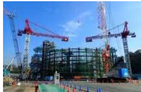
写真 1.1.3-3 非常口工事の状況
