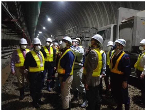
写真 1.2-1 NHSRCL職員 北海道新幹線トンネル工事視察
