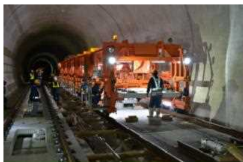
写真 1. 1. 1-5 軌道工事の状況
