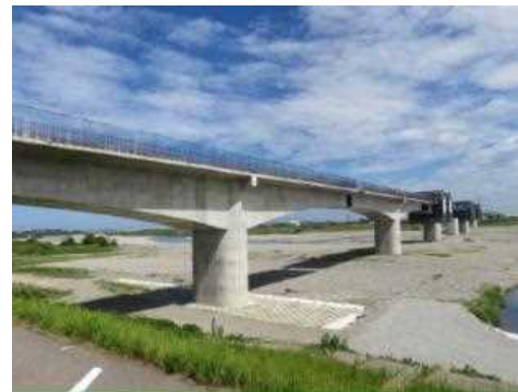
写真 1.1.1-3 手取川橋りょう（石川県 川北町）の施工状況
