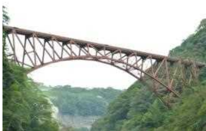
写真 1.1.3-4 第一白川橋りょう
