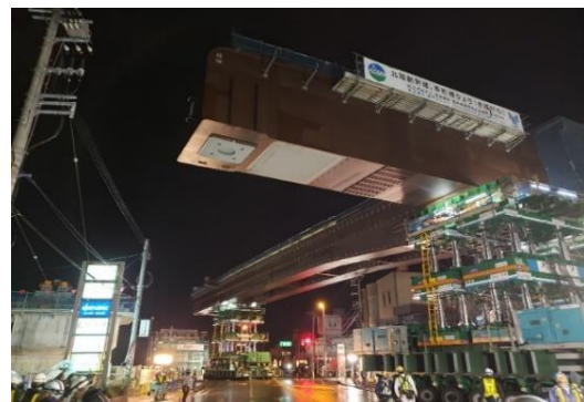
写真 1.1.1-3 幸町架道橋 （石川県小松市）の施工状況
