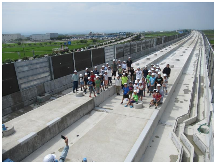
写真 1. 1. 4-4 現場見学会の状況（北陸新幹線、川北橋高架橋）
