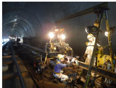
写真 1.1.1-5 軌道工事の実施状況
