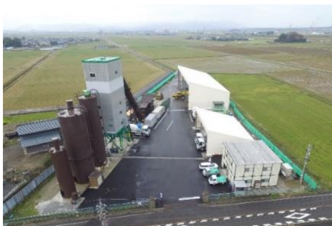
写真 1.1.1-4 仮設地上プラント設備（あわら市内）の稼働状況
