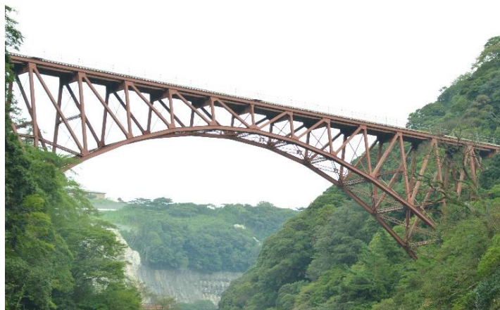
写真 1.1.3-2 第一白川橋りょう
