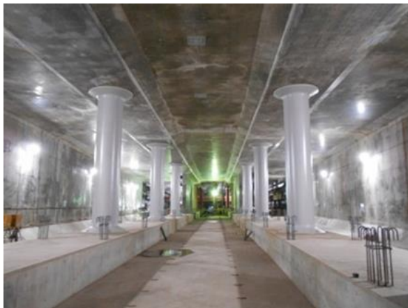
写真 1.1.2-5 新横浜駅の躯体構築の状況
