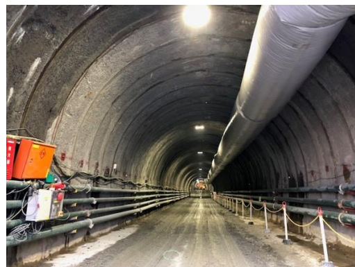
写真 1.1.1-1 内浦トンネル（東川） （北海道寿都郡黒松内町地内及び 磯谷郡蘭越町地内）の施工状況
