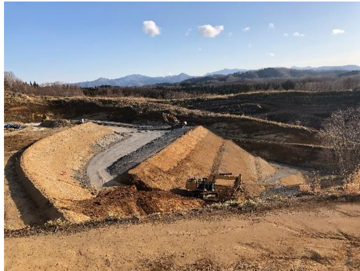
写真 1.1.1-2 対策土の受入地における覆土による対策工実施状況
