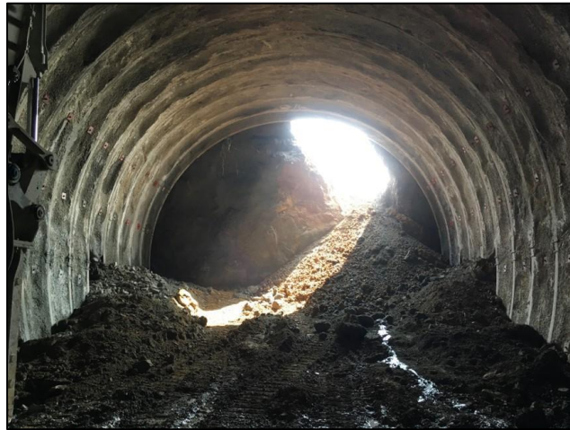
写真 1.1.1-6 久山トンネルの貫通状況
