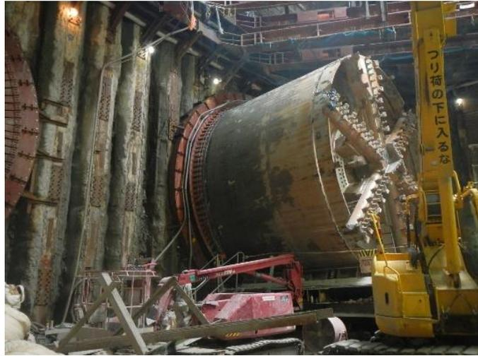
写真 1. 1. 2-2 網島トンネルの施工状況（シールド到達状況）
