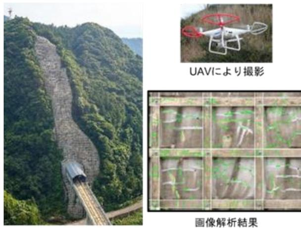
写真 1. 1. 1-7 ドローン(UAV)によるトンネル坑口部の空中撮影および画像解析
