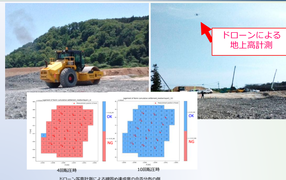
写真3-1-1-2 鉄道盛土におけるICT施工(土工)の検計 (北海道新幹線、八雲保守基地)
