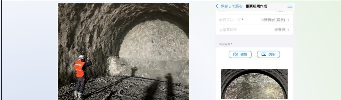
図3-1-4-2 トンネル切羽撮影とアプリ (AI切羽評価機能) への入力例
