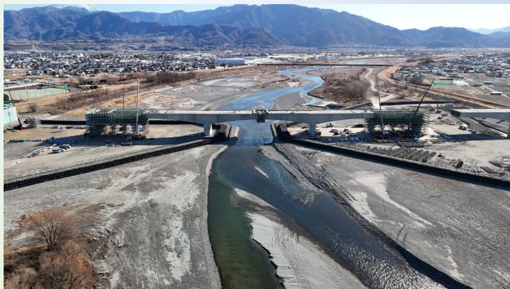
写真3-1-2-2 橋りょう工事の状況 (1) (釜無川橋りょう他 釜無川橋りょう)
