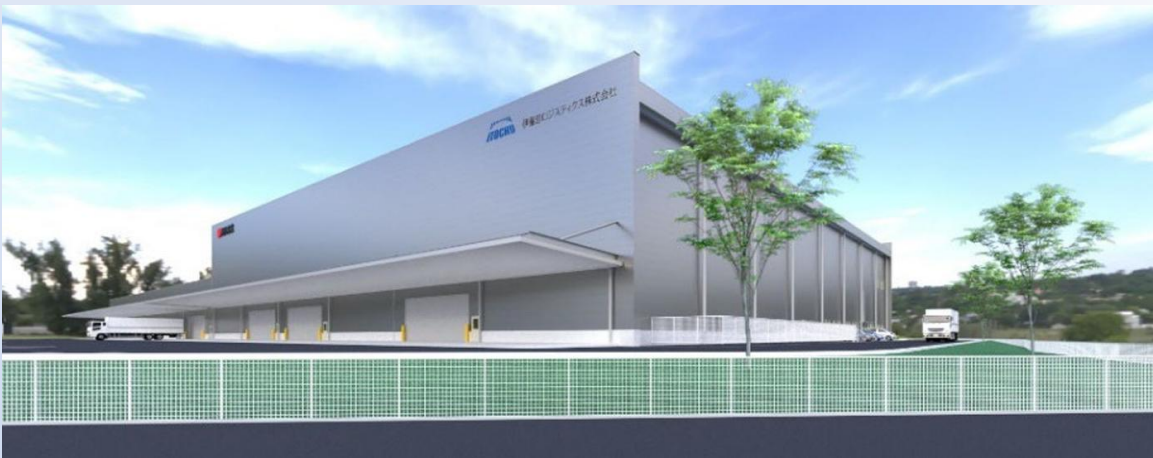
写真3-6-2-1 沼尻HLDGSの物流拠点(つくばメディカルロジスティクスセンター(第2期))(会社提供)
