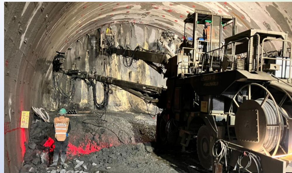
写真3-1-2-1 トンネル工事の状況 (中央アルプストンネル (山口))
