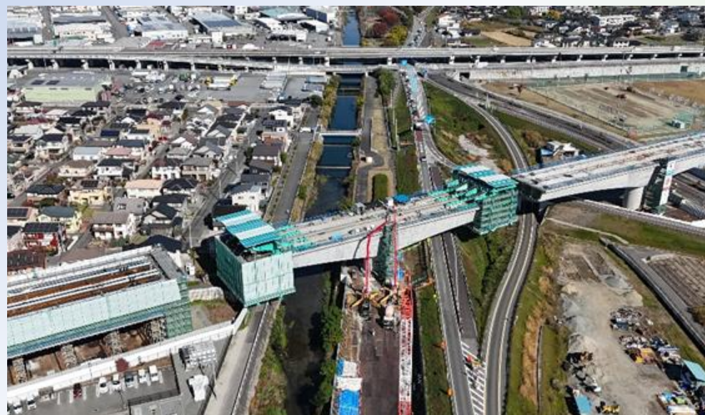
写真3-1-2-3 橋りょう工事の状況 (2) (釜無川橋りょう他 常永川橋りょう)
