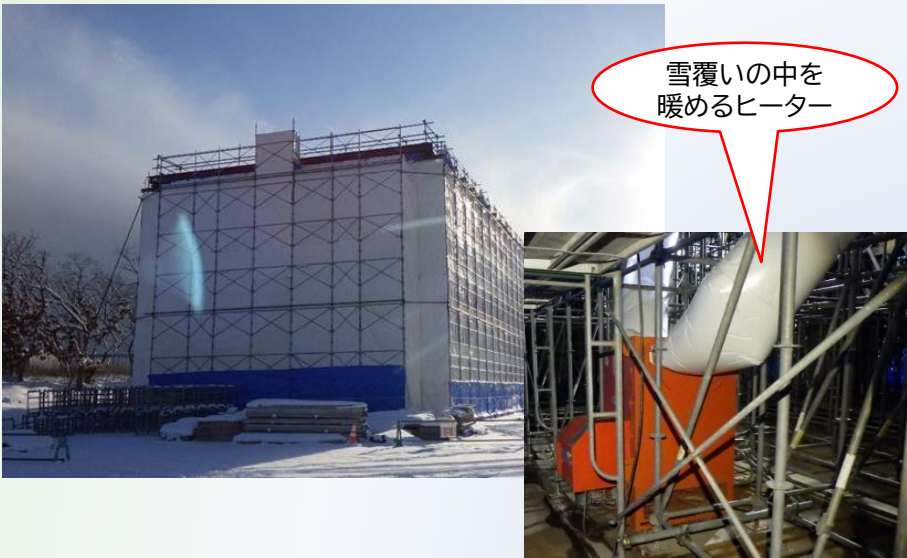
写真3-1-1-5 工程短縮策（冬季施工）
