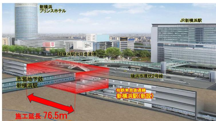
図 1.1.4-3 相鉄・東急直通線 新横浜駅のアンダーピニング施工箇所
