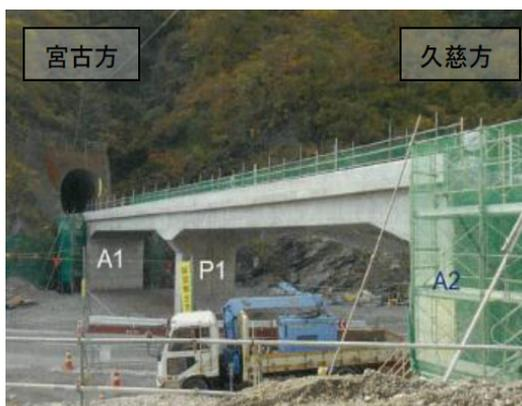
写真 1.1.3-8 GRS 一体橋梁施工状況
