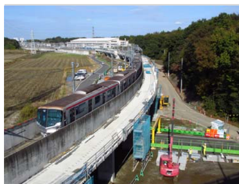
写真 1.1.3-5 上部工施工状況
