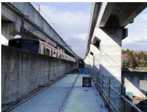
写真 1.1.3-4 R C桁施工状況
