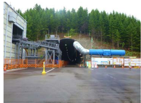
写真 1.1.1-3 昆布トンネル
