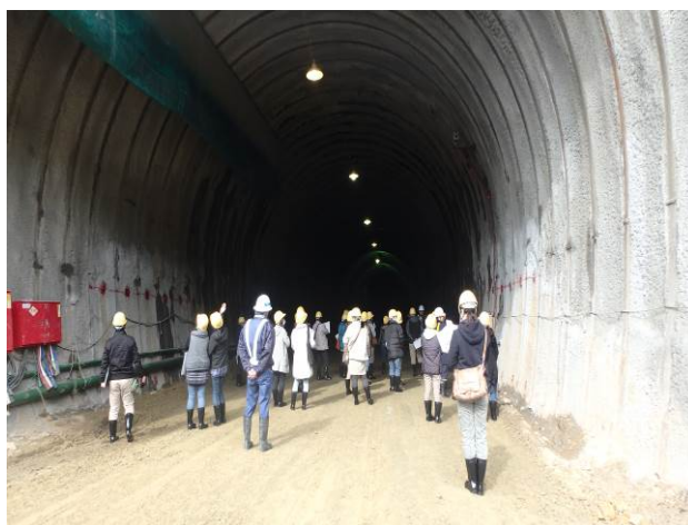
写真 1.7.3-3 現場見学会（長崎県大村市）
