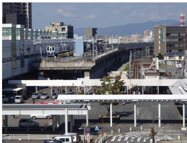
写真 1. 1. 3-3 えちぜん鉄道福井駅付近施工状況
