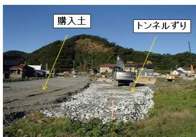
図 1.1.4-3 コスト構造改善策の取組み例② (ヤード整備材料にトンネルずりを使用することによるコスト改善)
