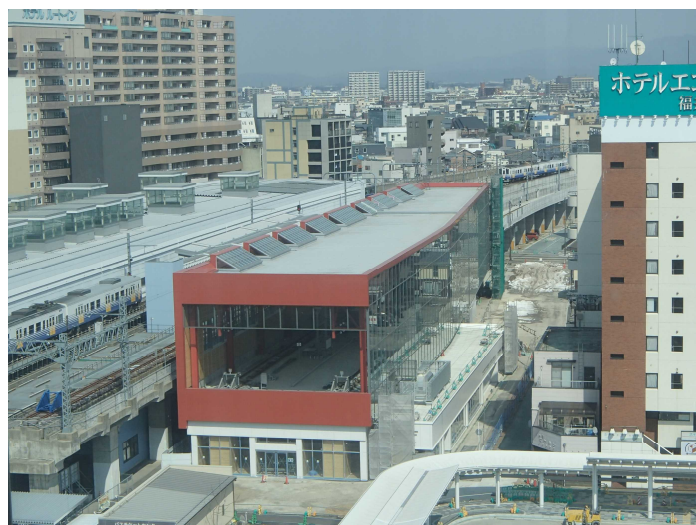
写真 1.1.3-1 えちぜん鉄道福井駅付近の施工状況
