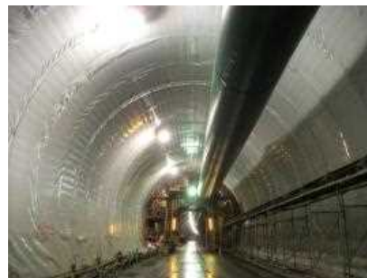
写真 1. 1. 1-1 渡島トンネルの施工状況
