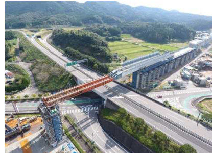
写真 1.1.1-3 袴野架道橋の施工状況
