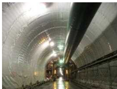
写真 1. 1. 1-1 渡島トンネルの施工状況
