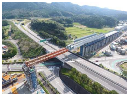
写真 1. 1. 1-3 袴野架道橋の施工状況
