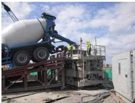
写真 1.1.4-1 北陸新幹線におけるFAコンクリートの適用（場所打ち杭）
