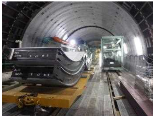
写真 1. 1. 2-4 新横浜トンネルの施工状況
