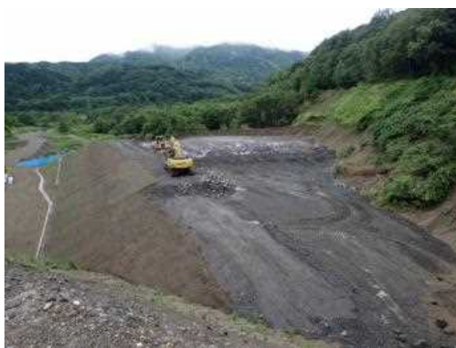
写真 1.1.1-2 発生土受入地の状況
