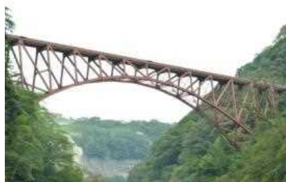
写真 1.1.3-4 第一白川橋りょう
