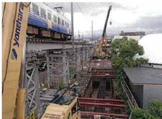
写真 1.1.3-1 営業線近接工事の状況
