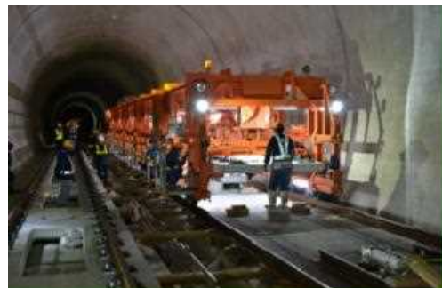
写真 1. 1. 1-5 軌道工事の状況
