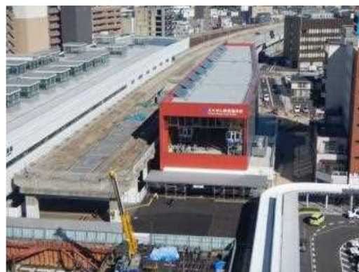
写真 1.1.3-2 計画線供用後、仮線を撤去完了した状況
