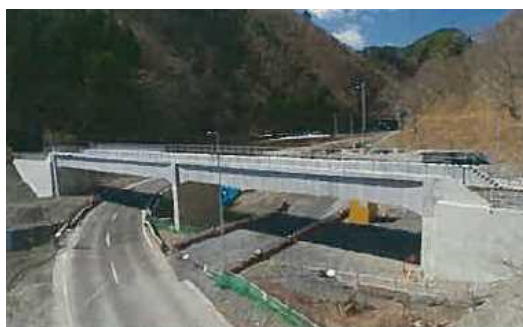
写真 1.1.4-1 建設された「GRS 一体橋梁」 三陸鉄道ハイペース橋梁
