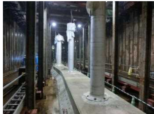
写真 1.1.2-3 新綱島駅（仮称）の躯体構築状況
