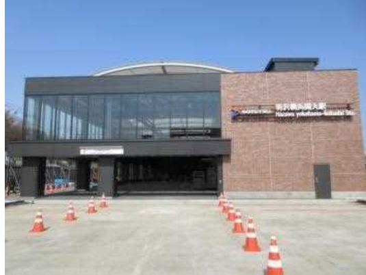
写真 1.1.2-2 羽沢横浜国大駅の外観
