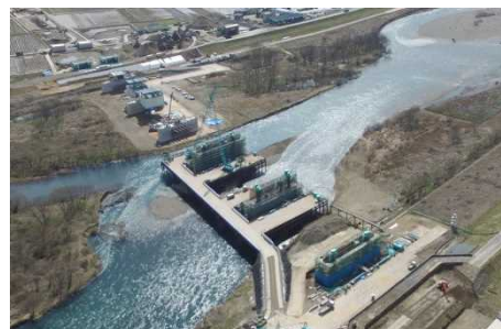
写真 1.1.1-6 九頭竜川橋りょう
