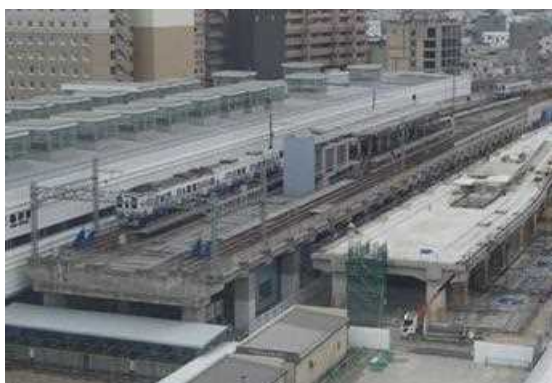
写真 1. 1. 3-6 えちぜん鉄道福井駅付近施工状況
