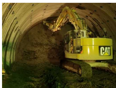
写真 1.1.1-5 野田追トンネル
