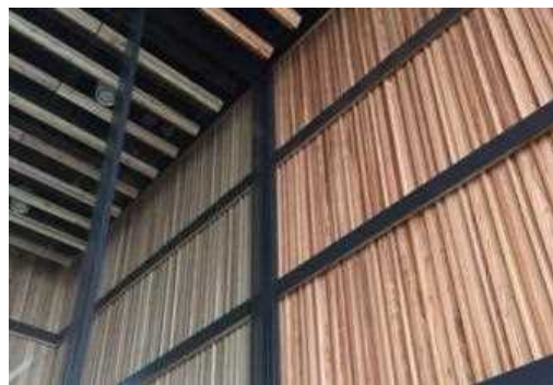
写真 1.1.1-4 新函館北斗駅の 駅舎内装の状況
