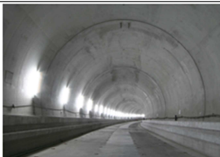
相鉄・JF環通線、西谷軌道敷設地
