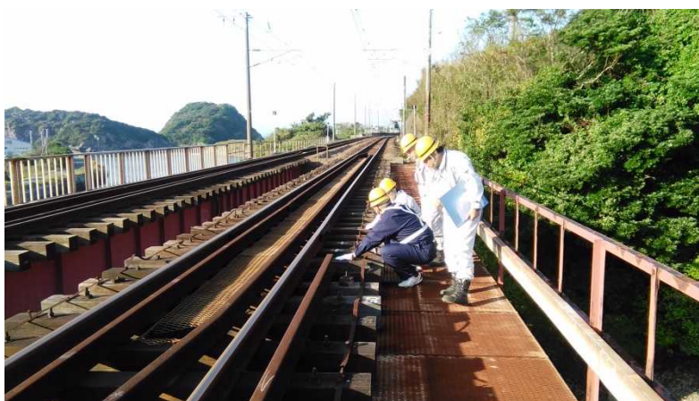
写真 1.1.3-8 現地訪問によるアドバイスの状況
