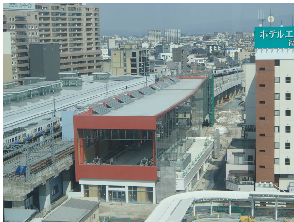
写真 1.1.3-6 えちぜん鉄道福井駅付近施工状況
