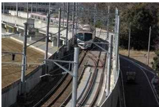
写真 1.1.3-7 つくばエクスプレス線（車両基地入出庫線複線化工事）完成状況
