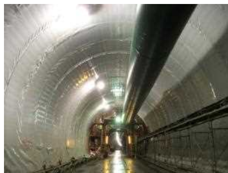
写真 1.1.1-5 渡島トンネルの施工状況
