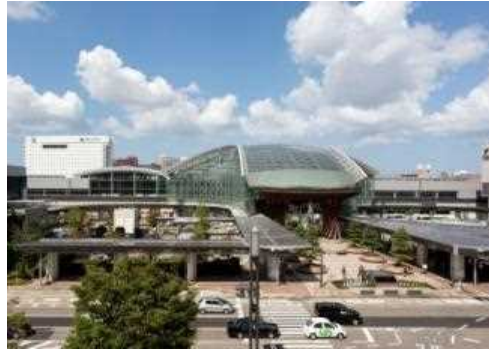
写真 1.1.1-2 金沢駅の全景
