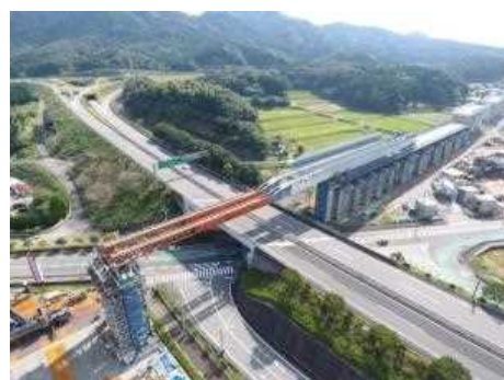
写真 1.1.1-7 袴野架道橋の施工状況
