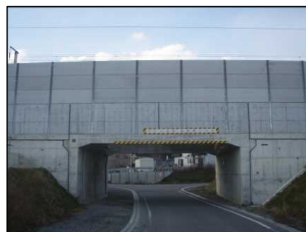
写真 1.1.4-1 中学校線架道橋完成状況
