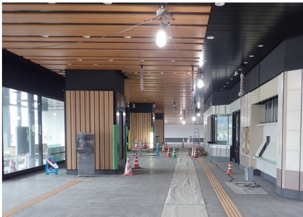
コンコース柱の仕上げ材に使用（工事中） 【嬉野温泉駅】
