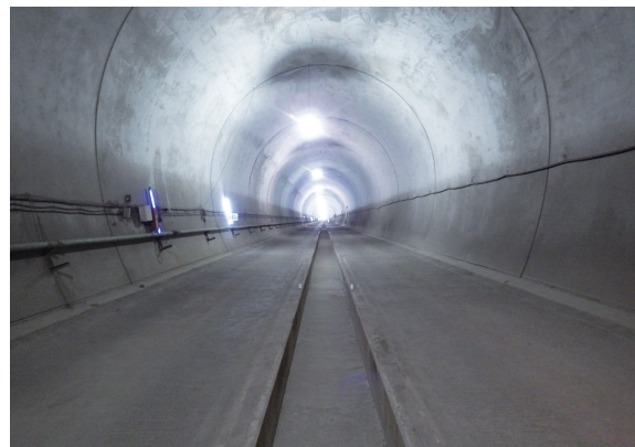
▲トンネルの覆工コンクリートへの利用
