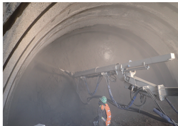
▲トンネルの吹付けコンクリートへの利用
