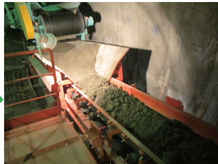
▲▶ベルトコンベアによる 土砂搬出（坑内・坑外）
