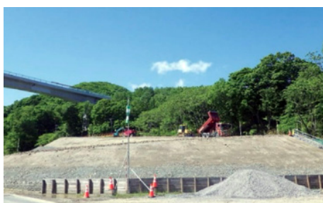
▲道路付替えの盛土造成に利用 (北海道新幹線(新函館北斗・札幌間))
