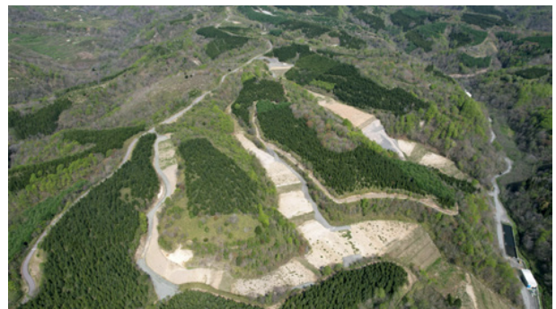
▲施工完了状況（浸透抑制工法）
