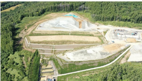
▲施工完了状況（原地盤活用+吸着層工法）
