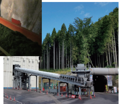
▲▶ベルトコンベアによる土砂搬出（坑内・坑外）
