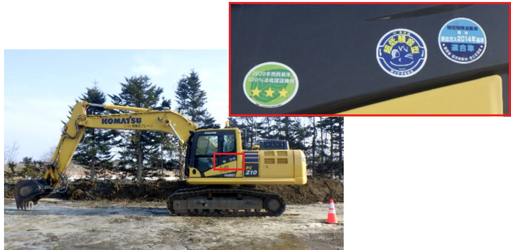
排出ガス対策型等の環境対策型建設機械の使用
