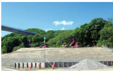
▲道路付替の盛土造成に利用 (北海道新幹線(新函館北斗・札幌間))
