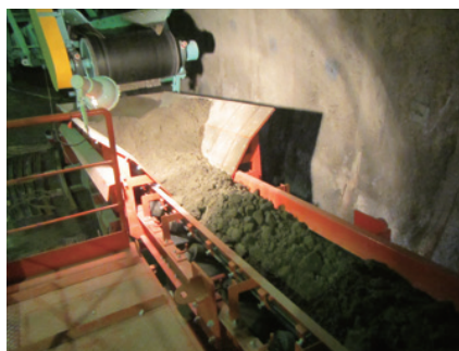
▲▶ベルトコンベアによる土砂搬出（坑内・坑外）
