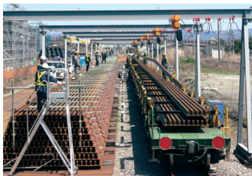
▲レールの取り出し
