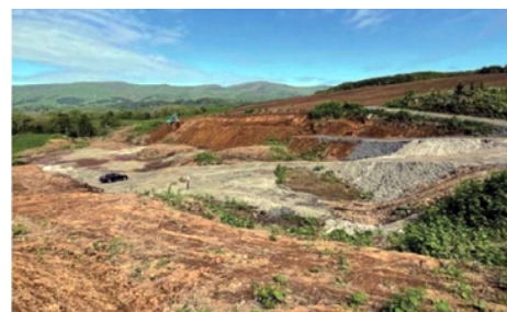
▲ほ場整備(畑)に利用 (北海道新幹線(新函館北斗・札幌間))
