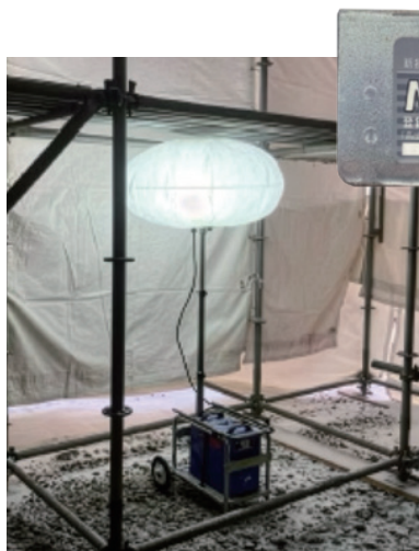
高出力LEDバッテリー投光器の使用
