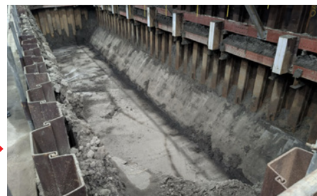
▲発生土を仮置きしている土砂ピット (北海道新幹線(新函館北斗・札幌間))
