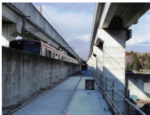
RC桁施工状況
