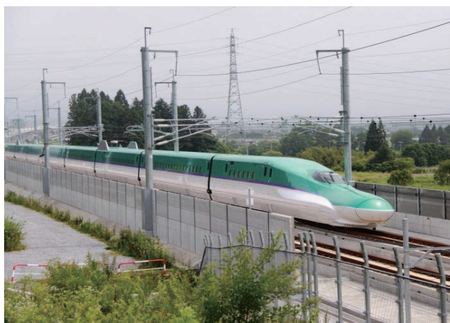
北海道 北斗市内（木古内・新函館北斗駅間）
