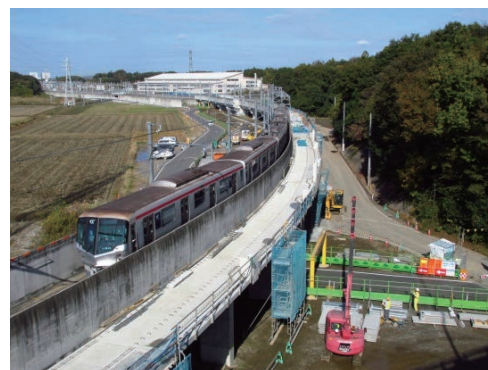
上部工事施工状況
