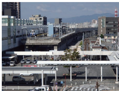
新幹線高架橋を利用した仮福井駅付近（仮線）
