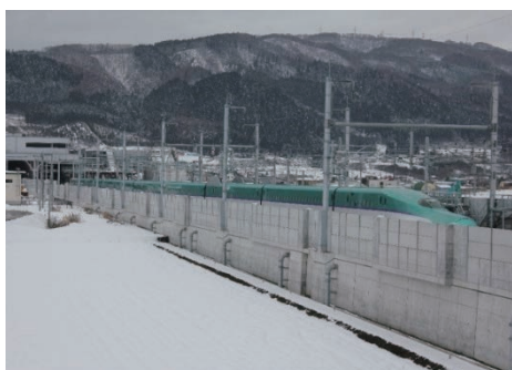
新函館北斗駅付近
