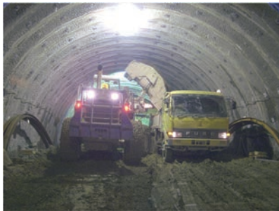
従来のタイヤ方式による搬出
