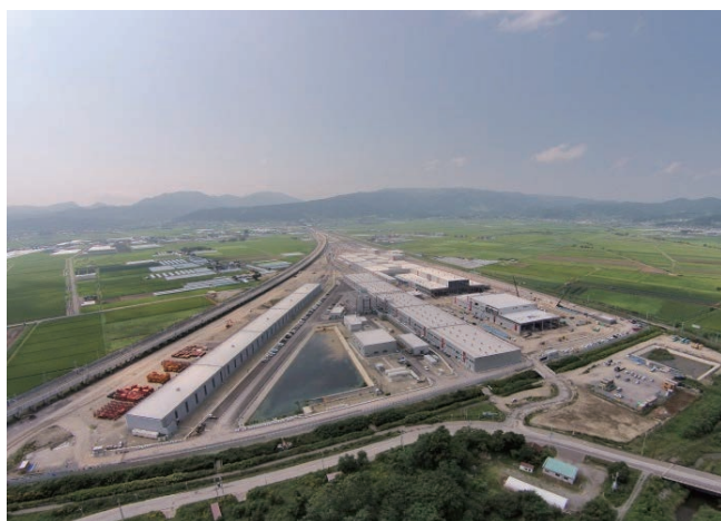
函館総合車両基地
