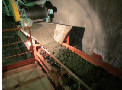
ベルトコンベアによる土砂搬出（坑内）
