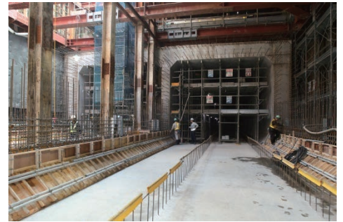
下北沢～世田谷代田間緩行線トンネル構築状況
