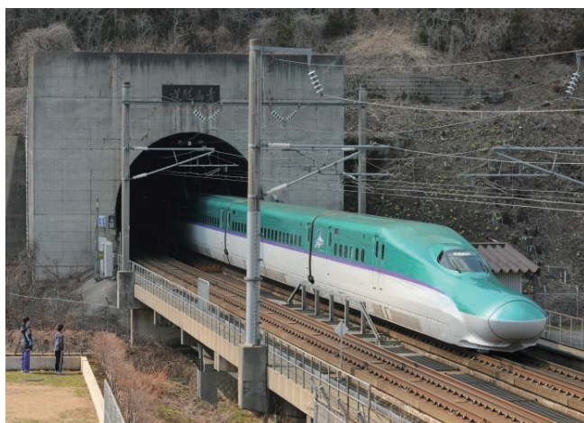
青森県 今別町内 青函トンネル入口付近 （奥津軽いまべつ駅・木古内駅間）
