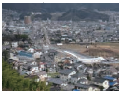
可部線の延伸区間
