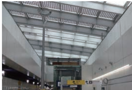
下北沢駅における自然採光と太陽光パネル （小田急電鉄㈱提供）
