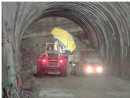
従来のタイヤ方式による搬出
