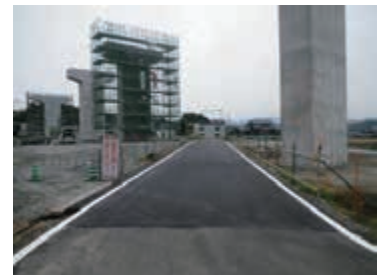
再生加熱アスファルト混合物による舗装
