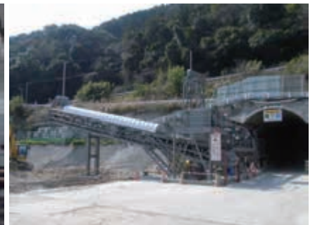
ベルトコンベアによる土砂搬出（坑外）
