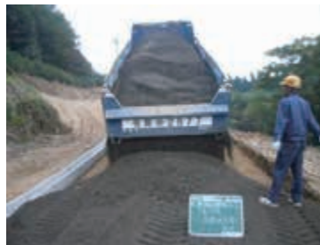
再生砕石の路盤材への使用
