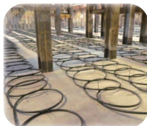
水平型地中熱交換器敷設状況 （小田急電鉄㈱提供）
