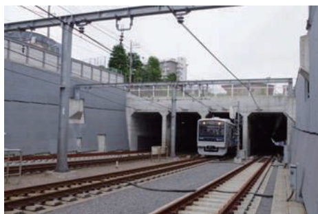
小田原線 世田谷代田～梅ヶ丘間軌道・電車線整備状況
