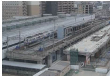
えちぜん鉄道福井駅付近施工状況
