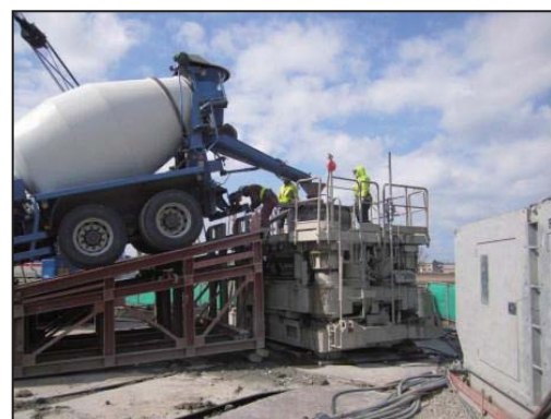
北陸新幹線におけるFAコンクリートの適用 （場所打ち杭）
