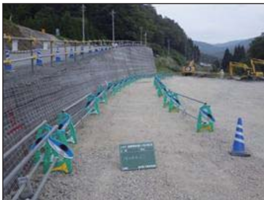
再生砕石の路盤材への使用
