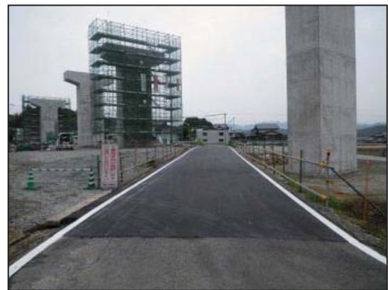
再生加熱アスファルト混合物による舗装
