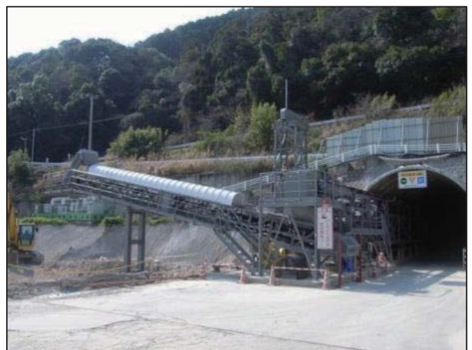
ベルトコンベアによる土砂搬出（坑外）
