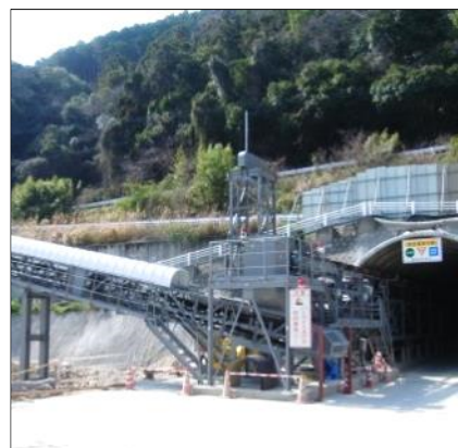
ベルトコンベアによる土砂搬出（坑内・坑外）
