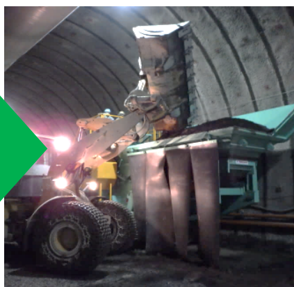
ベルトコンベアによる土砂搬出（坑内・坑外）
