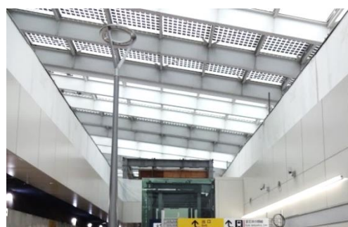
下北沢駅における自然採光と太陽光パネル （小田急電鉄㈱提供）
