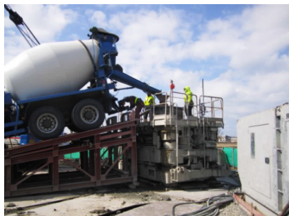
北陸新幹線におけるFAコンクリートの適用（場所打ち杭）
