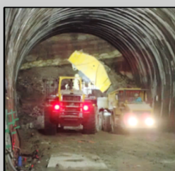
従来のダンプトラックによる搬出
