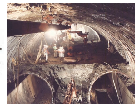
建設当時の掘削状況
