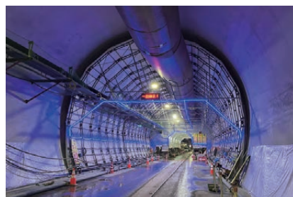
6 渡島トンネル
