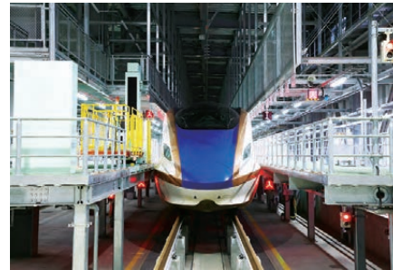
先頭車修繕装置（北陸新幹線）
