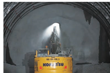
7 立岩トンネル
