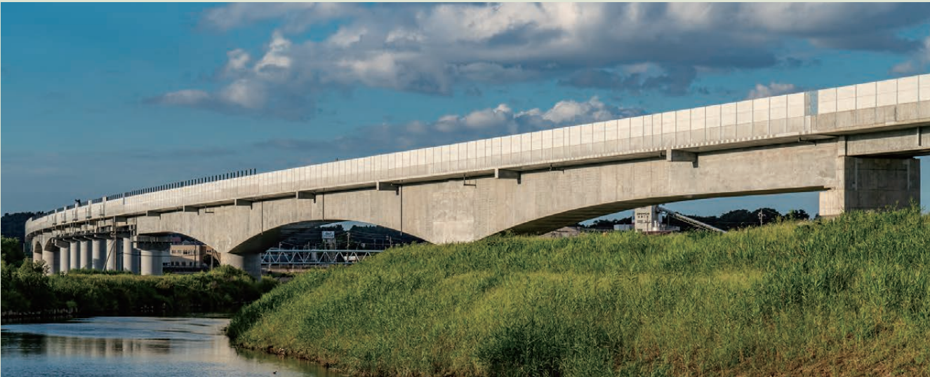
北陸新幹線 第2竹田川橋りょう
