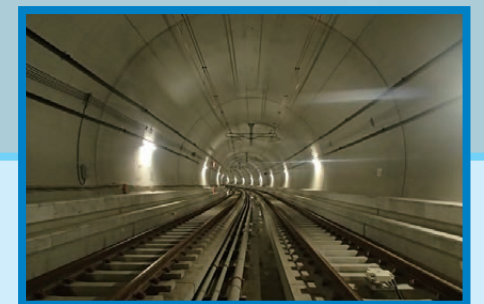
② 西谷トンネル
