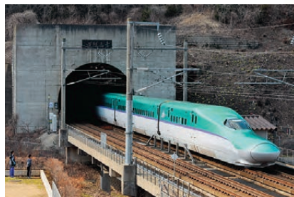
4 青函トンネル
