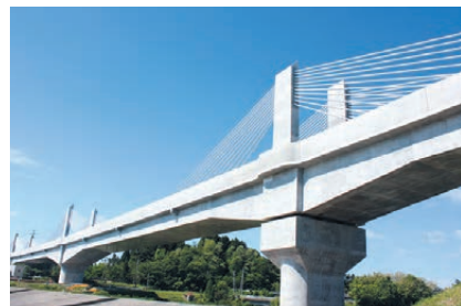
2 三内丸山架道橋
