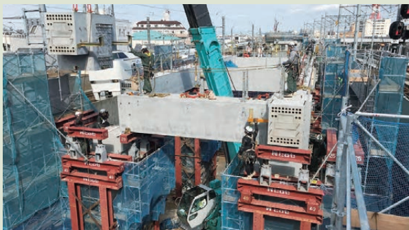
北陸新幹線 福井開発高架橋
