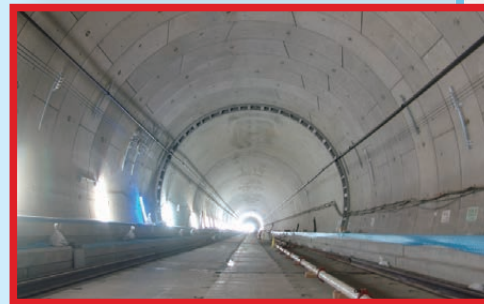
④ 羽沢トンネル 一台の掘進機でセグメント区間とSENS区間を連続で施工
