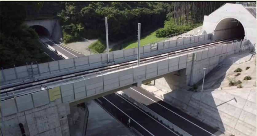
西九州新幹線 原種架道橋 (GRS 一体橋りょう)
