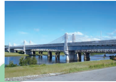
④ 神通川橋りょう
