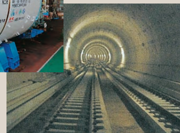
複線円形トンネル
