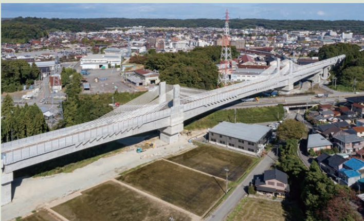
北陸新幹線 加賀細坪橋りょう
