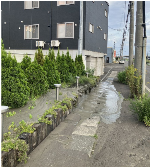
泥土等漏出時の様子（地表面） （６時００分頃）
