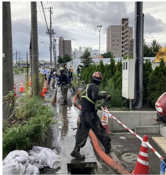
泥土等回収作業状況 （１２時００分頃）
