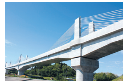
2 三内丸山架道橋
