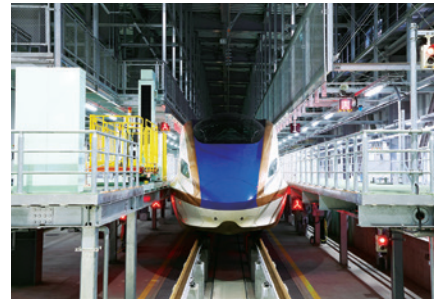
先頭車修繕装置（北陸新幹線）
