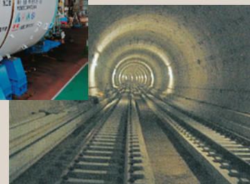
複線円形トンネル
