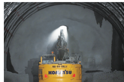
7 立岩トンネル
