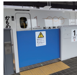
可動式ホーム柵（西九州新幹線）
