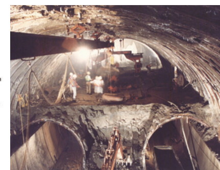
建設当時の掘削状況
