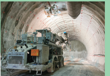
10 ニツ森トンネル
