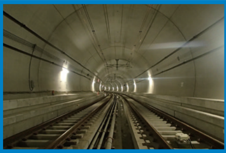
② 西谷トンネル
