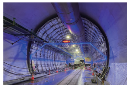
6 渡島トンネル
