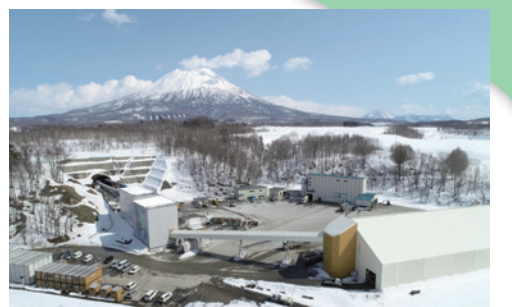
9 羊蹄トンネル
