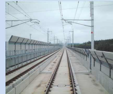
平板軌道スラブ (東北新幹線)
