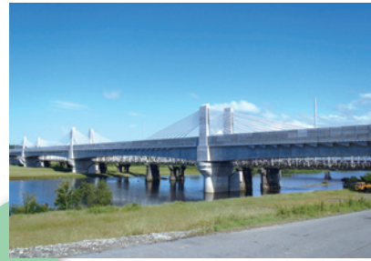
④ 神通川橋りょう
