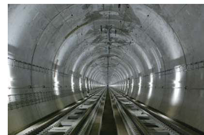
1 八甲田トンネル
