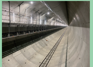
11 札樽トンネル
