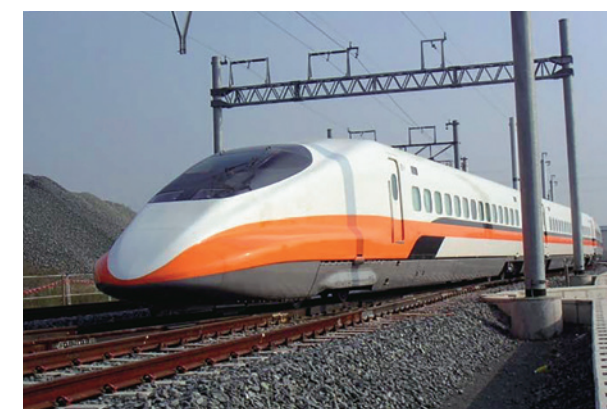
台湾高速鉄道建設(軌道・電気)への技術協力(台湾)
