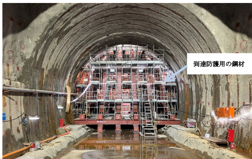
【写真】到達部の状況
