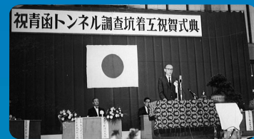
1971(昭46) 青函トンネル北海道側の斜坑掘削に着手
