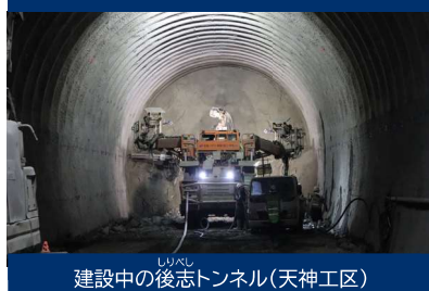
建設中の後志トンネル(天神工区)
