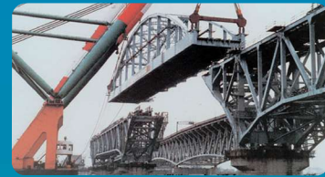
1973(昭48) 京葉線荒川放水路 橋りょうの建設
