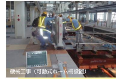
機械工事（可動式ホーム柵設置）
