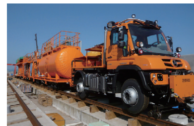
軌陸車（右手前）とモルタル注入車（左奥）
