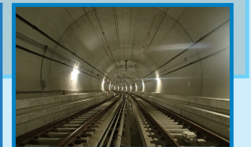
② 西谷トンネル
