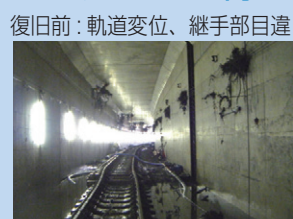
空港トンネル内
