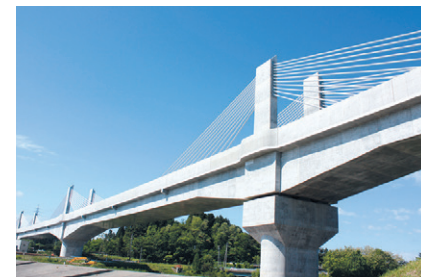
2 三内丸山架道橋
