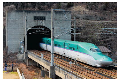
4 青函トンネル
