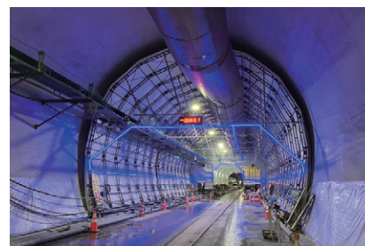
6 渡島トンネル
