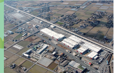
5 熊本総合車両基地
