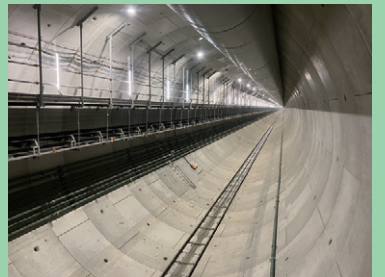
11 札幌トンネル
