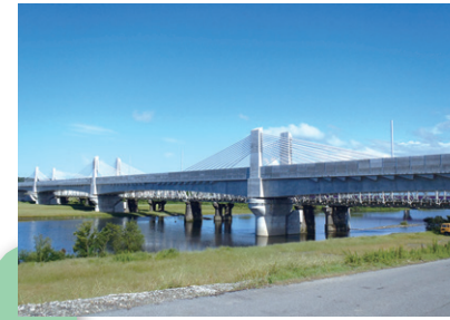
④ 神通川橋りょう
