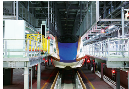
先頭車修繕装置（北陸新幹線）
