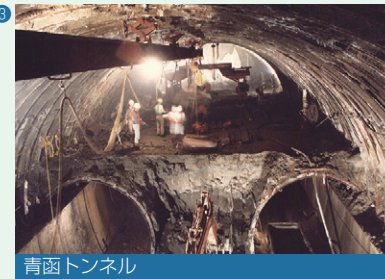
青函トンネル
