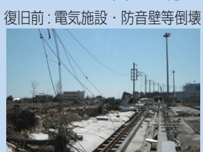
空港トンネル出入口付近
