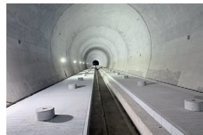
7 立岩トンネル
