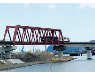
(大渡川橋りょうを走行する三陸鉄道車両)
