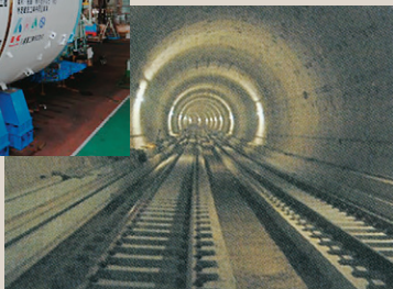
複線円形トンネル
