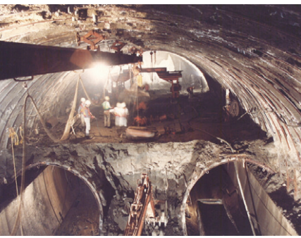
建設当時の掘削状況
