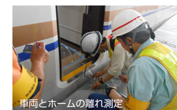
車両とホームの離れ測定
