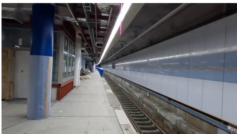
【新綱島駅ホーム】
