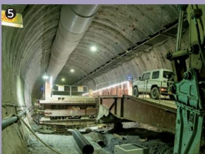
①発破後防護カーテンが開けられる ②ズリの搬出作業 ③鋼製支保工の建て込み作業 ④鋼製支保工の細かい位置合わせは人間の手で行う ⑤改良インバート栈橋。トンネル基板部の施工のための栈橋
