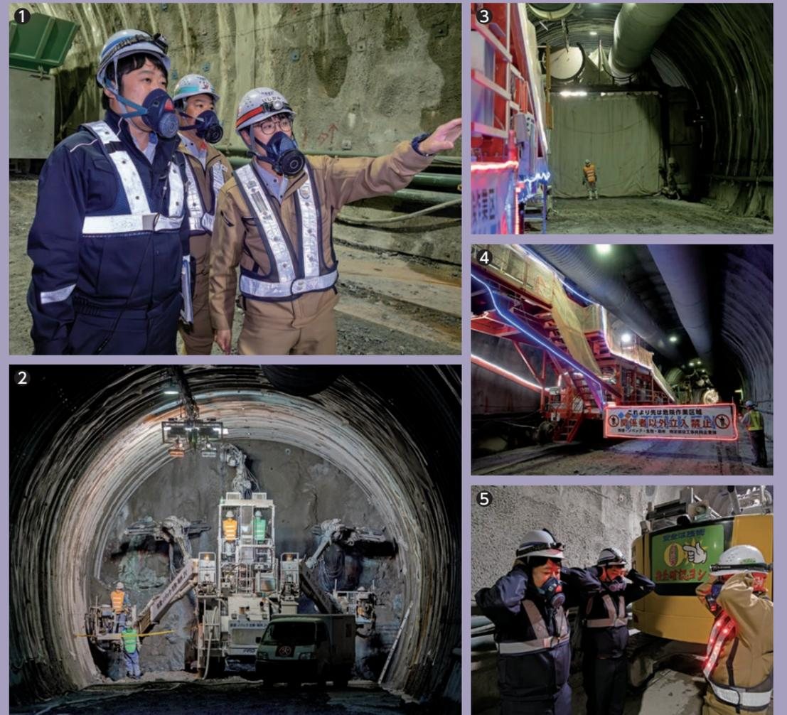
①切羽状況について協議する古屋工事長(左)とJV職員 ②削孔作業 ③防護カーテンが閉じられる ④装束作業が終わり、立入禁止区間が設定される ⑤発破の瞬間、耳を防護する
