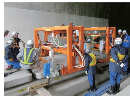
軌道スラブ調整作業の電動化
