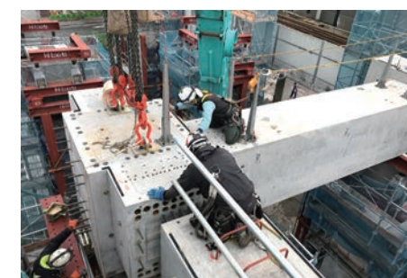
工場制作した大型プレキャストコンクリート（北陸新幹線、福井開発高架橋）
