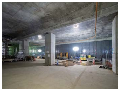
新綱島駅地下1階の改札口予定地。柱の手に自動改札が設置され、奥がラッチ（改札）内。左に見える足場部分には地上からのエレベーターが設置される
