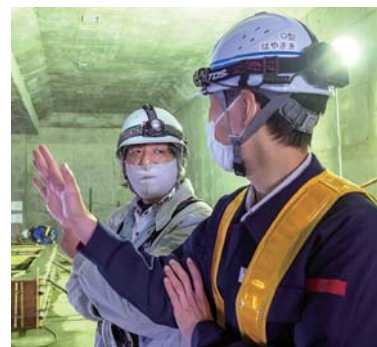
横浜市営地下鉄グリーンラインの建設にも携わった株式会社渡辺組の西條大輔現場代理人は、「軌道敷設までにやるべきことが多い点が地下駅建設の難しさ」と語る
