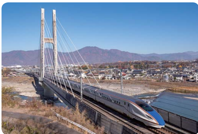
新幹線初の斜張橋である 第二千曲川橋りょう
