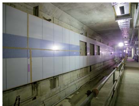
設置が完了した新綱島駅ホームの対向壁。鶴見川の流れる水色のパネルで表現
