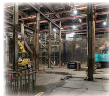
横浜市営地下鉄ブルーライン新横浜駅の躯体。既に開口部が設けられているが現時点では仮設壁で塞いでいる
