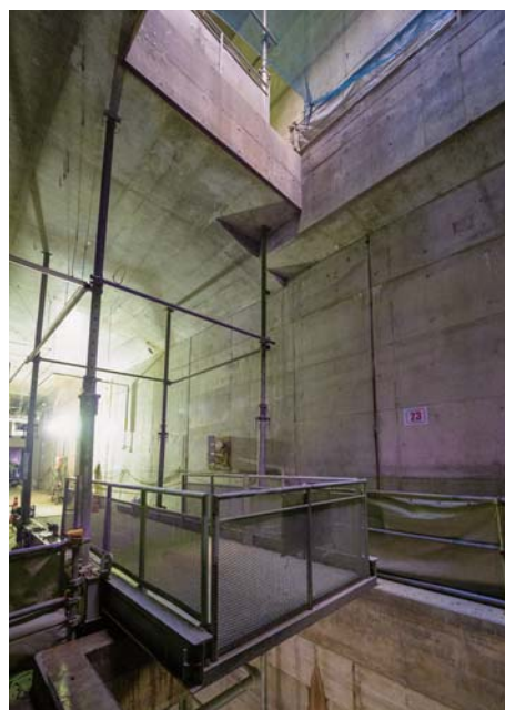
地下2階の仮設開口部。スライド式のステージがせり出して資機材を受け取る仕組みだ
