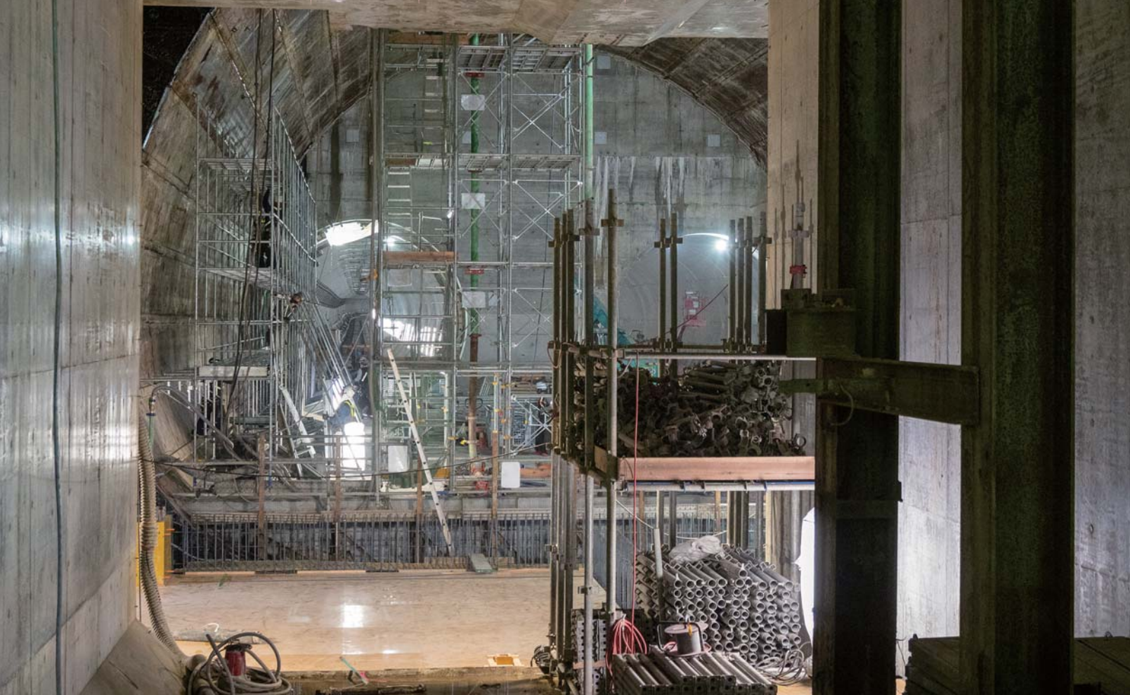
新綱島駅の終点方では土木工事が進行中。延長 34.5 m の複線トンネルの先は、単線トンネル 2 つに分かれる
