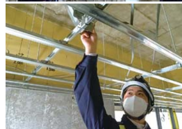
安全設備の確認は何よりも重要な職務だ。耐震性を向上させる耐震ブレースが計画どおりしっかり取り付けられているか確認する
