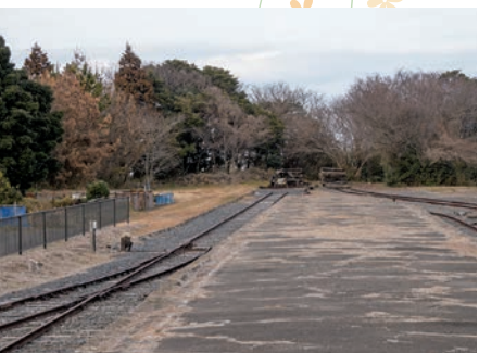
延伸工事の着工を待つ終端部
