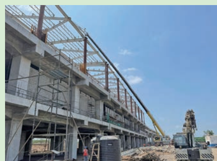
建設中のスーラト駅
