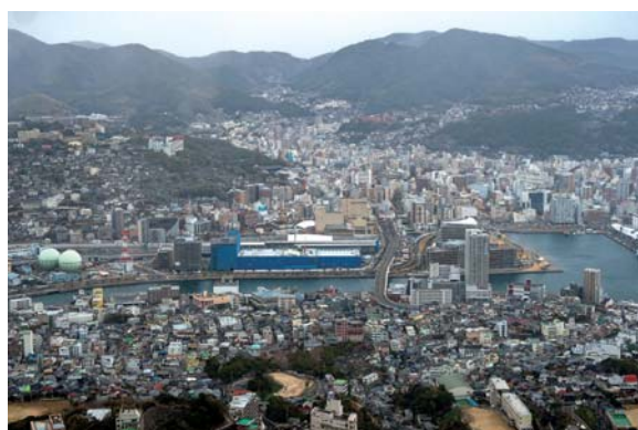
稲佐山から見る長崎駅。その手前には大型コンベンション施設やホテルの建設も進んでいる
