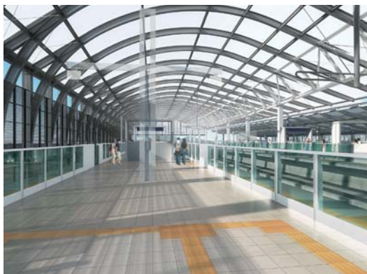
ホームの完成予想パース。Y字の柱と外壁側の柱のみでアーチ状の屋根を支え、大空間を実現する
