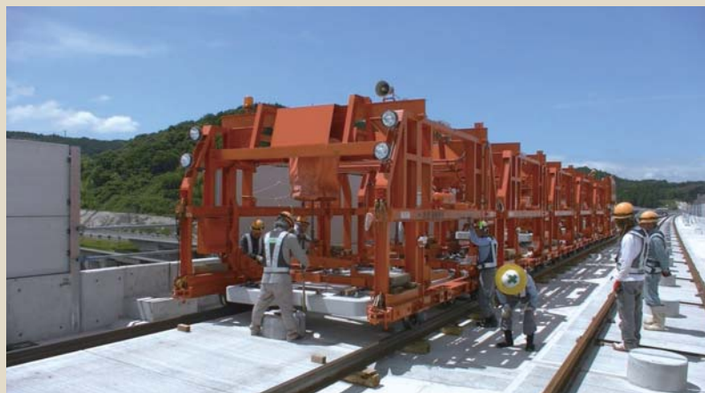
軌道スラブの敷設風景
