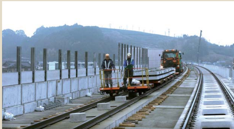
軌道スラブの運搬風景
