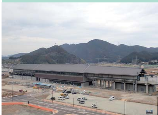
嬉野温泉駅の施工状況
