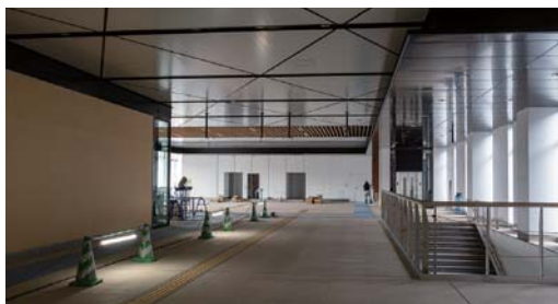
二柱式を採用したことで広い空間となった諫早駅改札内コンコース。正面奥のトイレの手前には押し花を挟み込んだガラススクリーンが設置される
