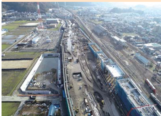
敦賀車両基地路盤の施工状況
