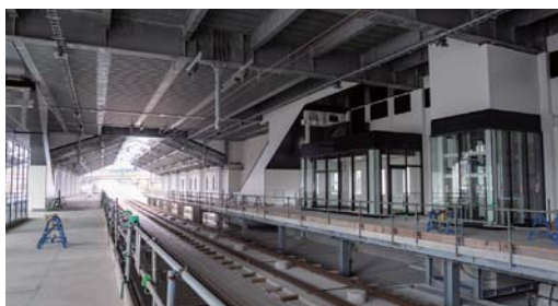
エレベーターなども設置され完成に近付いた諫早駅ホーム。軌道の下には駅を支える地中梁が横方向に埋め込まれている
