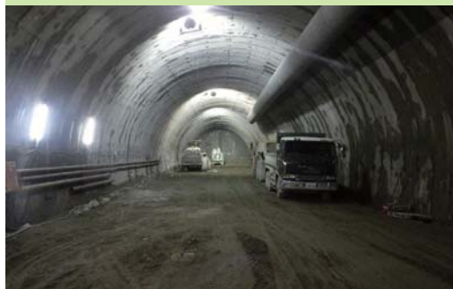
中央アルプストンネル（山口工区）の掘削状況
