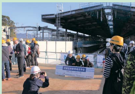
建設中の武雄温泉駅を望みながら記念撮影
