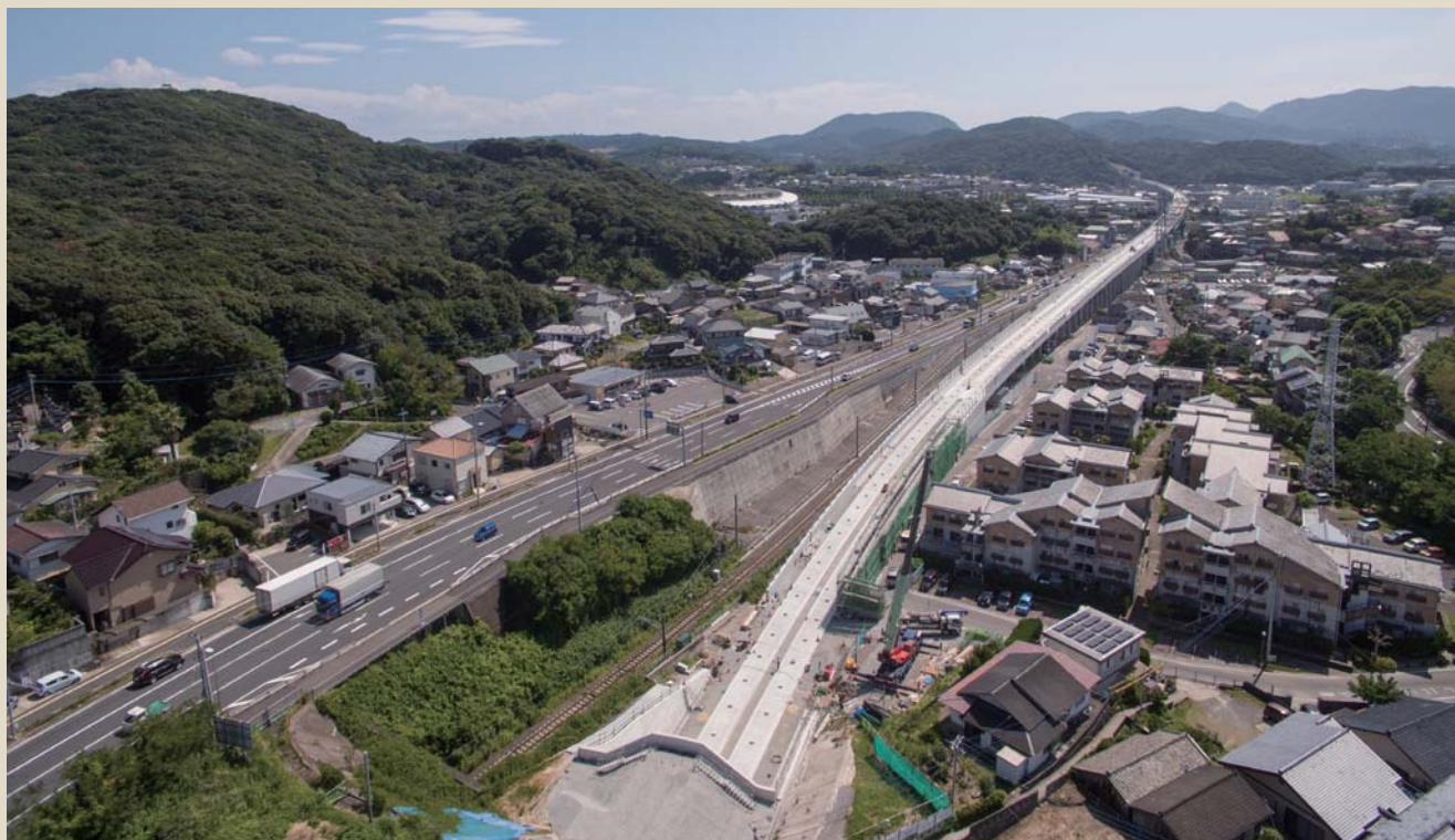
最後のコンクリート打設を行った宇都橋りょう（長崎県諫早市）
