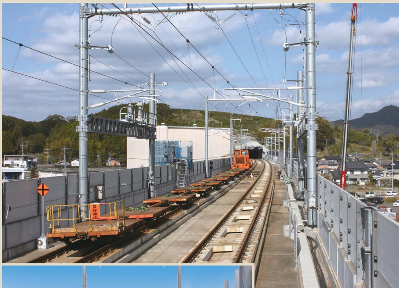
嬉野温泉駅付近を走行する工事用車両 (軌道モーターカー)
