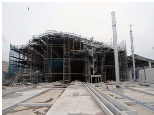
起点側から見た長崎駅。足場の撤去後は右に見えるらせん階段から屋根に上がり点検等を行う
