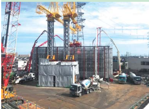
札幌トンネル（札幌工区）施工状況 （シールドマシンの発進立坑施工状況）
