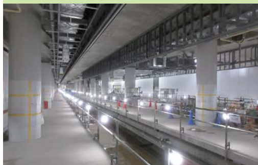
新横浜駅（仮称）の地下ホーム施工状況
