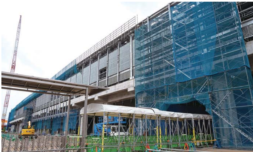
建設が進む長崎駅。手前の通路は旧駅舎方面にあるロータリーや商業施設等と新駅（在来線）を結ぶ仮設通路だ
