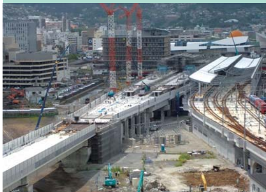
長崎駅の施工状況（写真左が新幹線工事、写真右は他事業による在来線工事）
