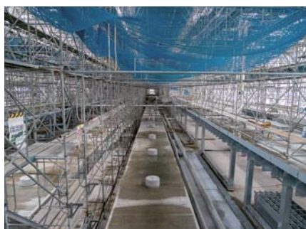
軌道スラブの敷設を待つ長崎駅ホーム。無数の足場は 3 月に膜屋根の施工が終了した後撤去される
