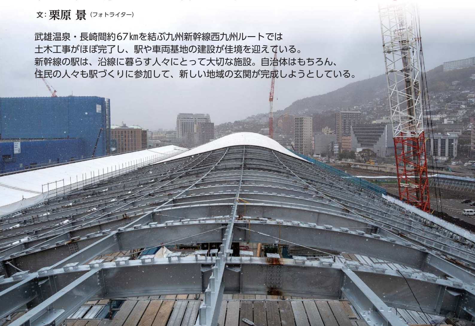
令和2年11月16日から膜屋根の施工が始まった長崎駅の屋根部は、縦方向・横方向それぞれに曲線を描く。右手には解体が進む在来線の旧ホームが見える
