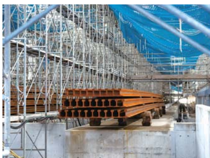
ホーム全体に足場が組まれているため、必要なレールは先に搬入し貯積してある
