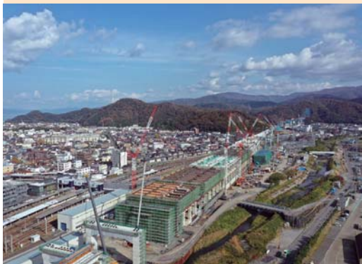
敦賀駅高架橋の施工状況
