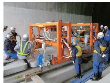
軌道スラブ調整作業の電動化
