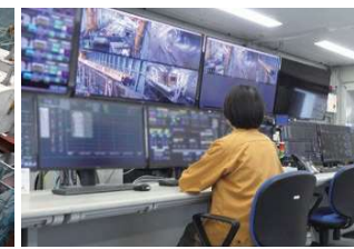
シールドマシン操作室（北海道新幹線、札幌トンネル）
