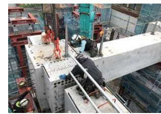
工場制作した大型プレキャストコンクリート（北陸新幹線、福井開発高架橋）
