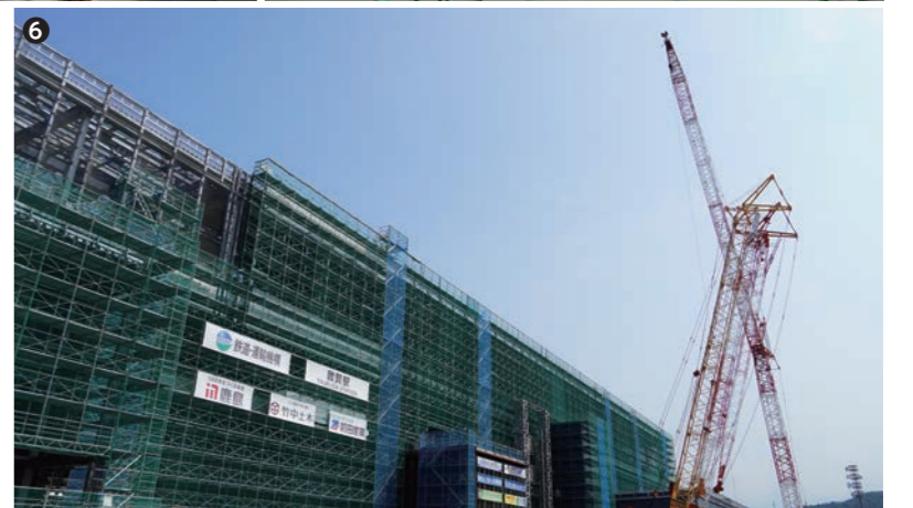
①出席者が見守る中、吊り上げられる最後の鉄骨梁 ②鉄骨梁への署名 ③鉄骨梁を吊り上げる様子 ④新幹線ホーム ⑤新幹線コンコース ⑥建設中の敦賀駅外観
