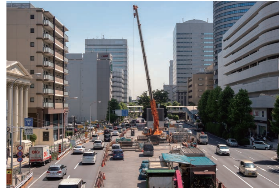
環状2号線の地下で工事が進められている
