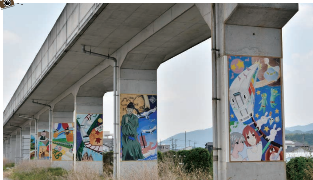
橋脚の一部には地元の学生によって絵が描かれている
