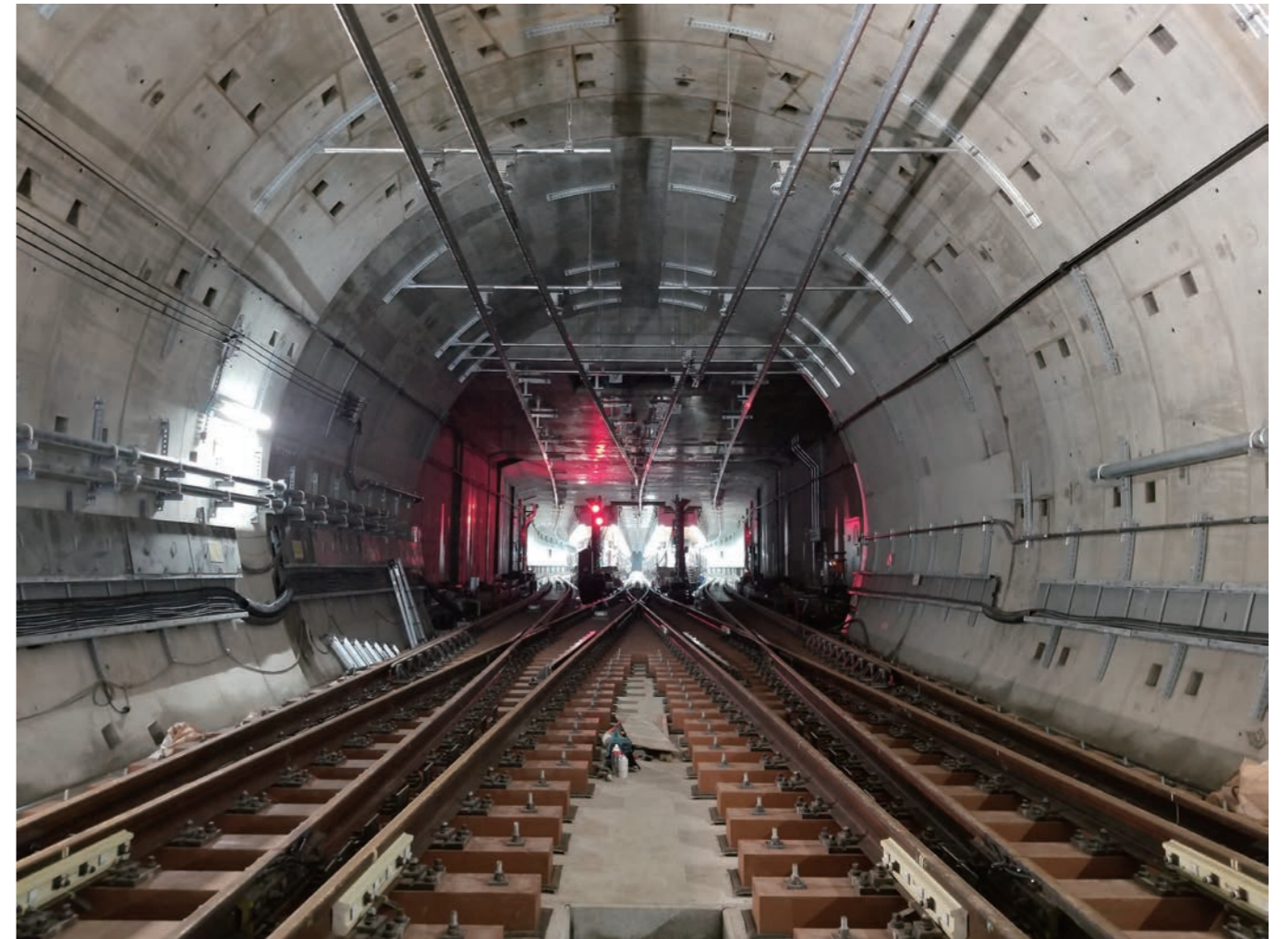
羽沢トンネルから見た新横浜駅
