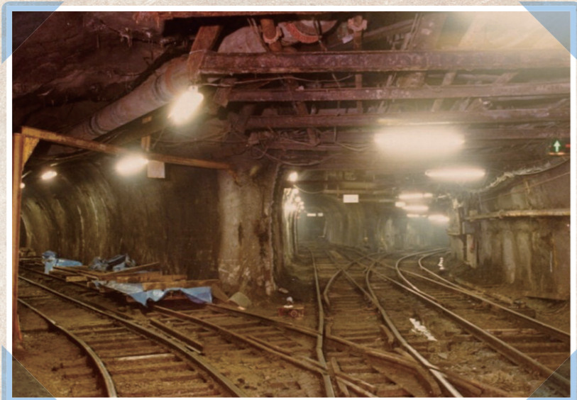
四方木立坑坑底部付近
