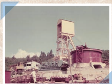
中山トンネル中山工区の立坑
