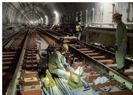
信号・保安装置関連作業
