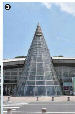
③待合室は矢じりをイメージしたユニークな外観
