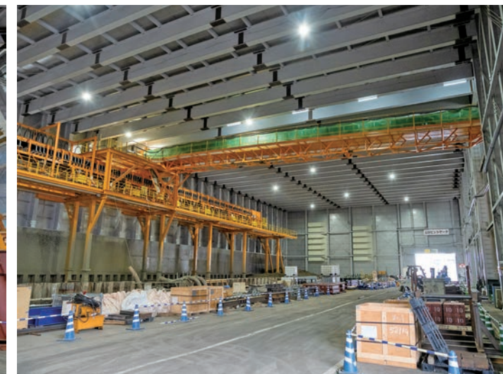
掘削土はベルトコンベアで運ばれる（札幌工区）
