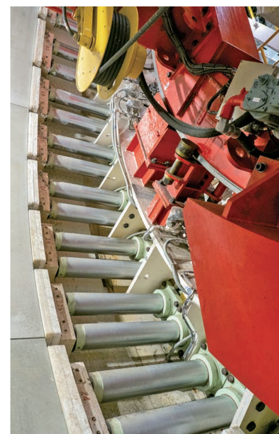
セグメントを押すシールドジャッキ（札幌工区）
