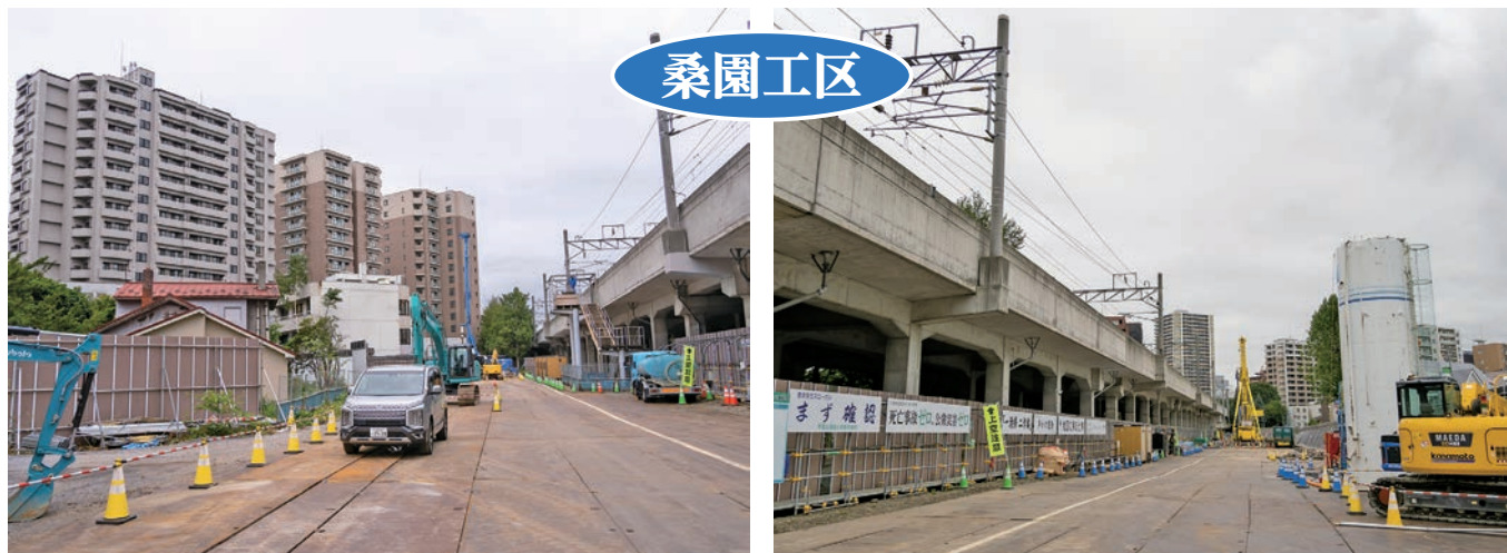
桑園工区は札幌駅に近く、建設現場の近くにはマンションや住宅も多い
