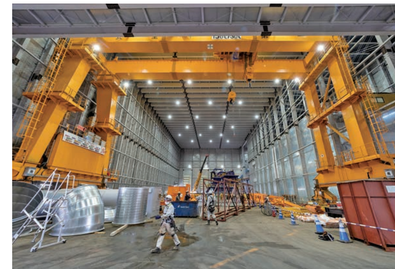
防音ハウス内。市街地が近いので、騒音には特に配慮している（札幌工区）
