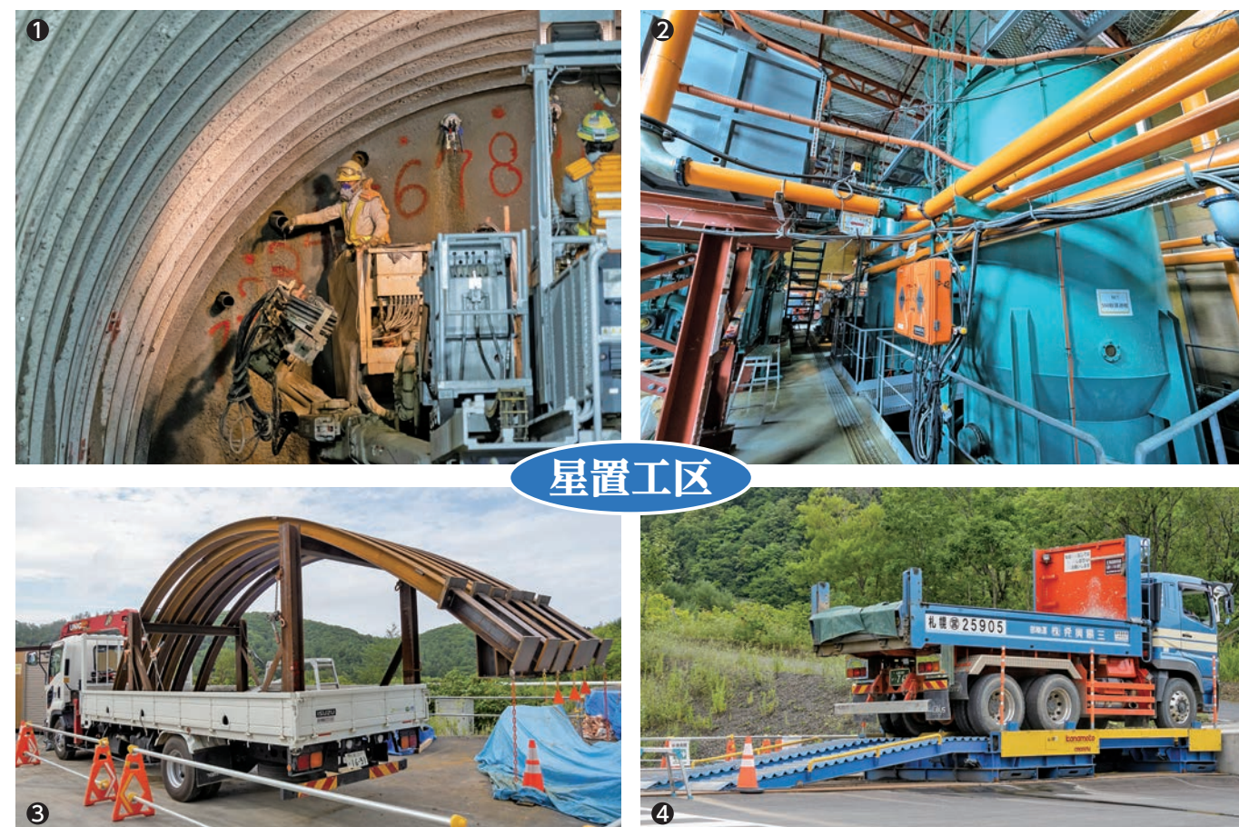
① AGF工法の施工状況 ②濁水処理施設 ③トンネル空間を保持する鋼製支保工 ④ダンプカーの車輪洗浄機
