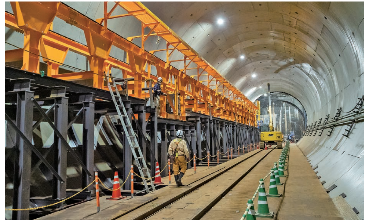
整備中のベルトコンベア（札幌工区）
