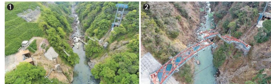
①旧橋の撤去完了 ②アーチ部分の閉合 ③復旧工事の全景
