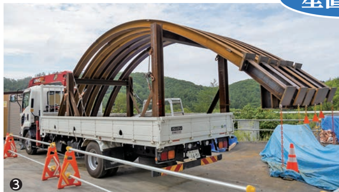
① AGF工法の施工状況 ②濁水処理施設 ③トンネル空間を保持する鋼製支保工 ④ダンプカーの車輪洗浄機
