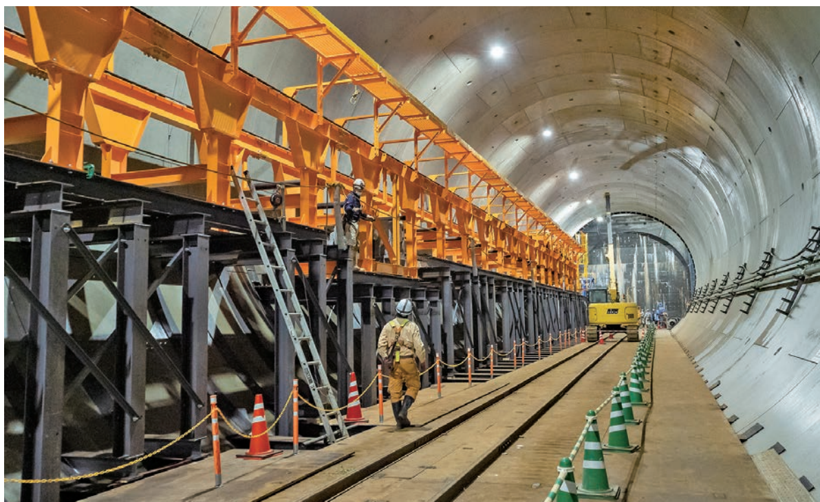
整備中のベルトコンベア（札幌工区）
