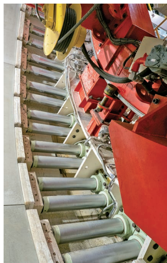
セグメントを押しシールドジャッキ（札幌工区）
