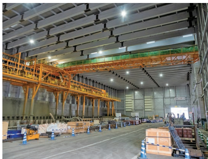
掘削土はベルトコンベアで運ばれる（札幌工区）
