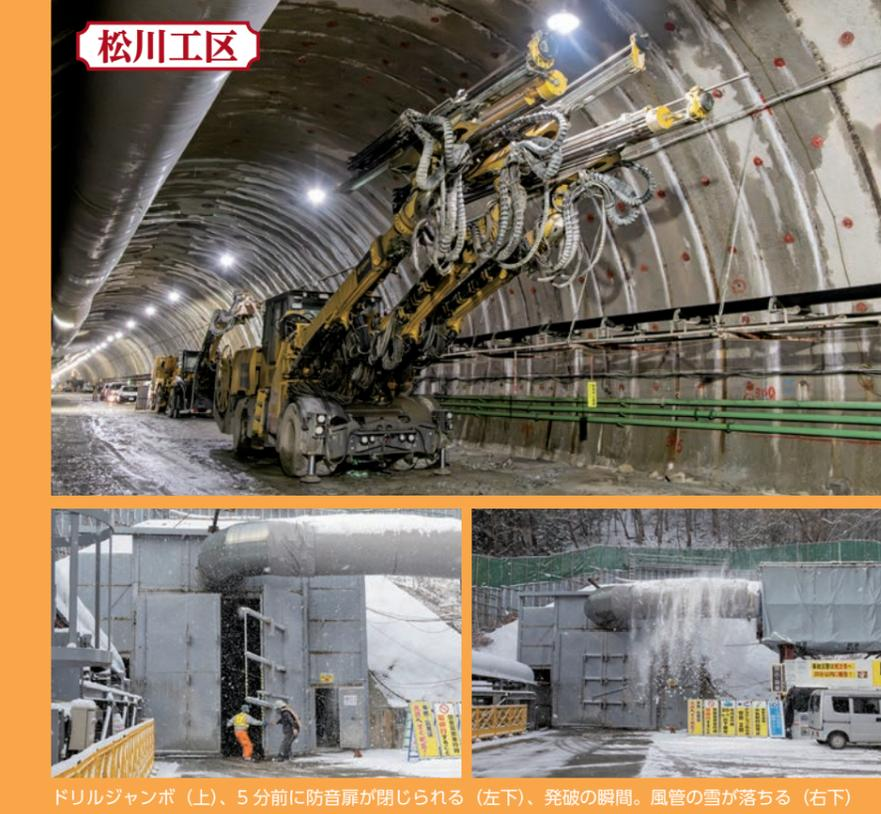
ドリルジャンボ(上)、5分前に防音扉が閉じられる(左下)、発破の瞬間。風管の雪が落ちる(右下)
