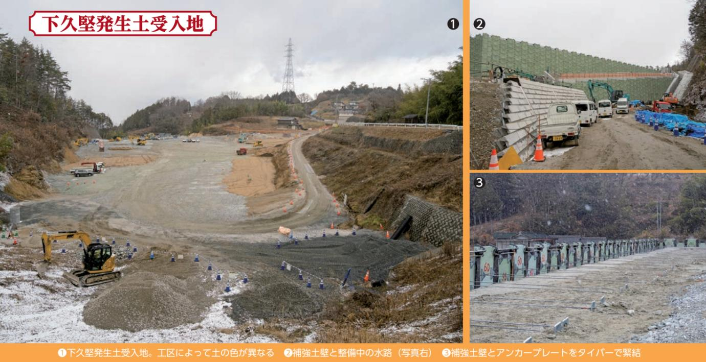
①下久堅発生土受入地。工区によって土の色が異なる ②補強土壁と整備中の水路（写真右） ③補強土壁とアンカープレートとをタイバーで緊結
