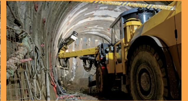
切羽に鋼管を建て込み AGF 工法の薬液を注入する
