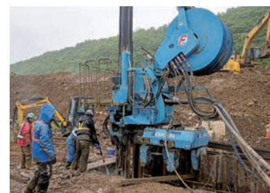
油圧式杭圧入引抜機
