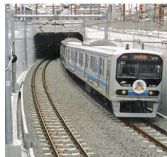
りんかい線／工事中の品川シーサイド駅
