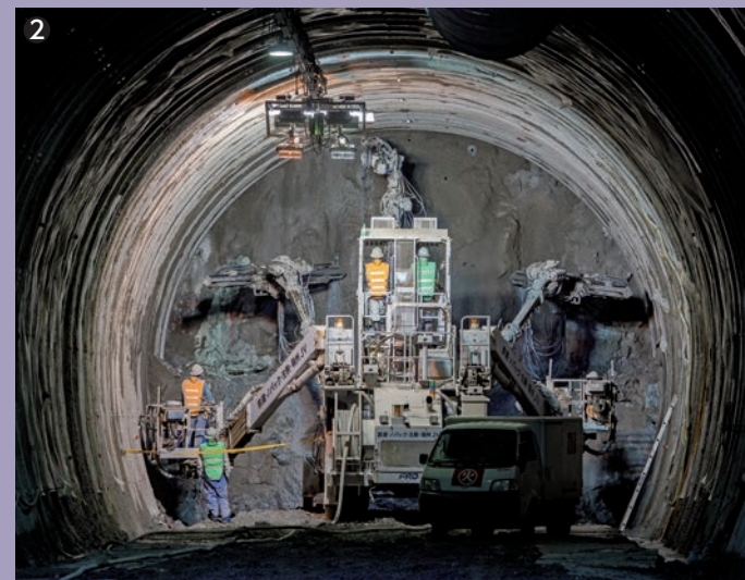
①切羽状況について協議する古屋工事長(左)とJV職員 ②削孔作業 ③防護カーテンが閉じられる ④装薬作業が終わり、立入禁止区間が設定される ⑤発破の瞬間、耳を防護する
