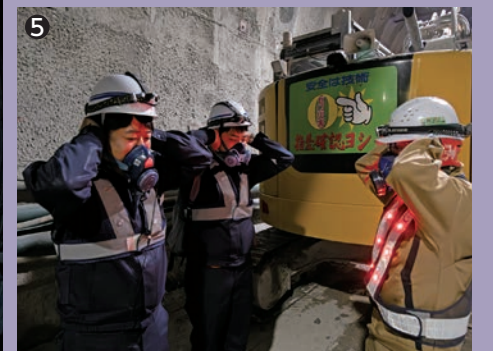
①切羽状況について協議する古屋工事長(左)とJV職員 ②削孔作業 ③防護カーテンが閉じられる ④装薬作業が終わり、立入禁止区間が設定される ⑤発破の瞬間、耳を防護する
