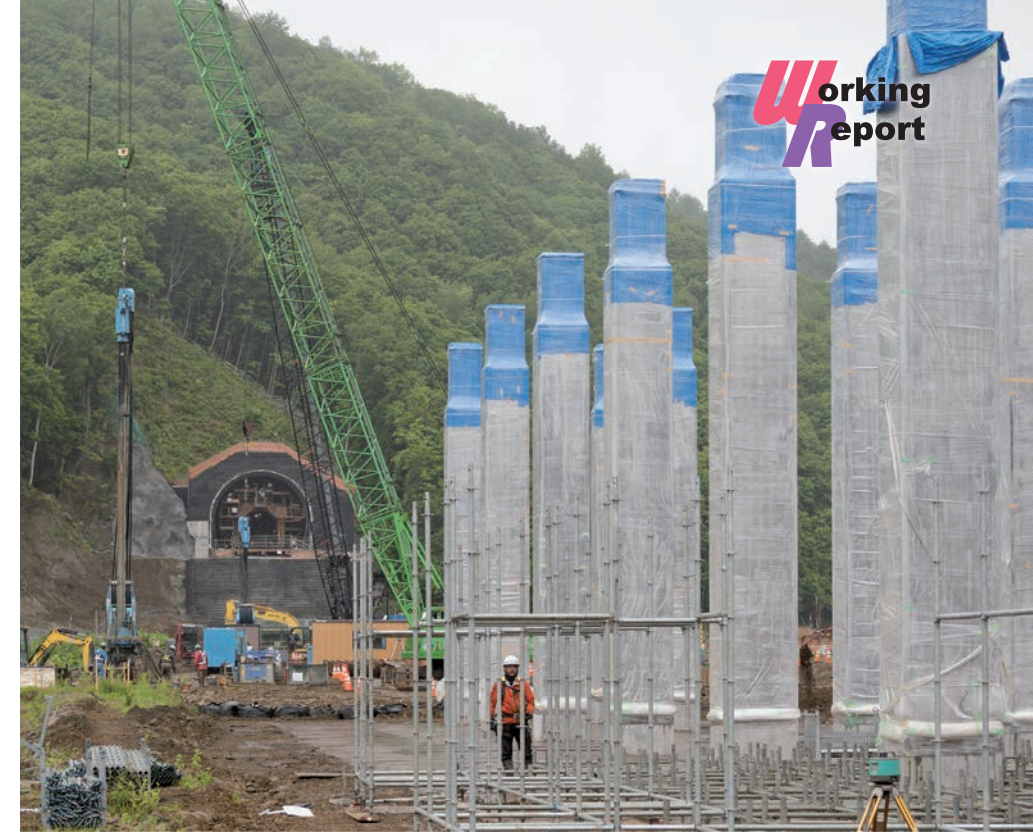
ラーメン高架橋の橋脚と後志トンネル
