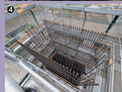
①大型スクリーンで施工状況を説明する薬師寺現場代理人 ②国道を越える部分では深礎工法を採用している ③ニッ森トンネル坑口から見た明治高架橋施工現場全景 ④鉄筋が打ち込まれた初期の段階のRC橋脚 ⑤RC橋脚の足場 ⑥平板載荷試験の様子
