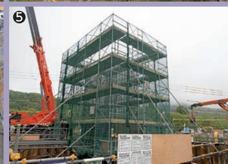
①大型スクリーンで施工状況を説明する薬師寺現場代理人 ②国道を越える部分では深礎工法を採用している ③ニッ森トンネル坑口から見た明治高架橋施工現場全景 ④鉄筋が打ち込まれた初期の段階のRC橋脚 ⑤RC橋脚の足場 ⑥平板載荷試験の様子
