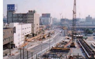
りんかい線／工事中の品川シーサイド駅
