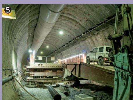
①発破後防護カーテンが開けられる ②ブリの搬出作業 ③鋼製支保工の建て込み作業 ④鋼製支保工の細かい位置合わせは人間の手で行う ⑤改良インパート栈橋。トンネル基板部の施工のための栈橋
