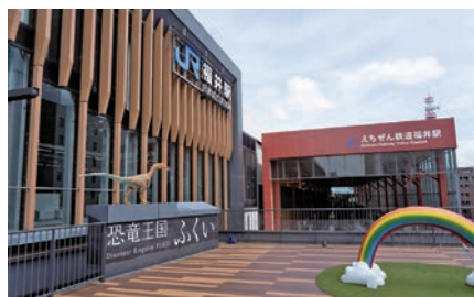
プラットホームの天井は木調ルーバーでくつろぎの空間を演出（上）。左は JR 福井駅。右はえちぜん鉄道福井駅（下）
