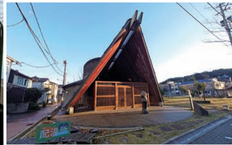
片山津温泉配湯所。ここから各旅館へ温泉を配湯している
