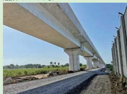
ビリモラ・スーラト間の高架橋
