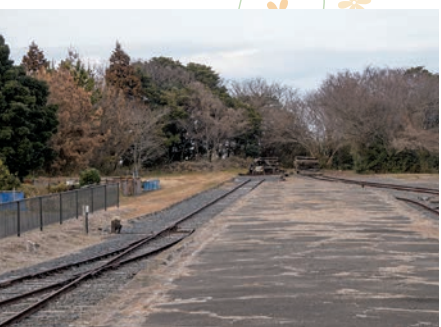
延伸工事の着工を待つ終端部
