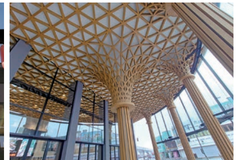
雨天利用が可能な屋外の屋根付き「アフレア広場」
