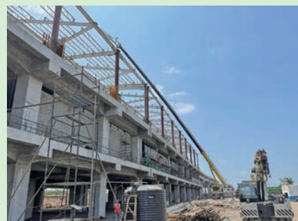
建設中のスーラト駅
