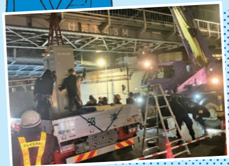
列車運行時間外で、迅速かつ確実に変電所へ機器を搬入
