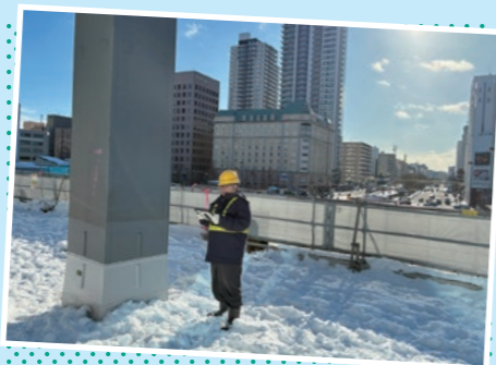
雪の積もる札幌で構造物の柱を目視確認
